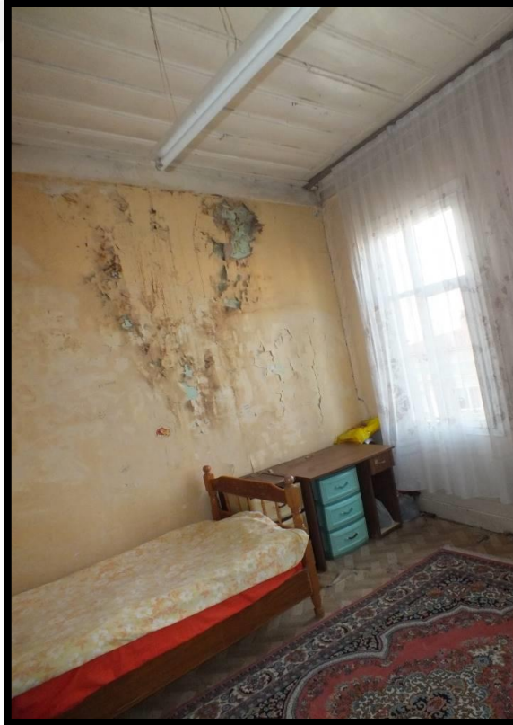
Görsel 332. Tescilli Ev 9, İkinci Kat Odalardan Görünüş (Trabzon Rölöve ve Anıtlar Müdürlüğü Sokak Sağlıklaştırma Projesinden)
