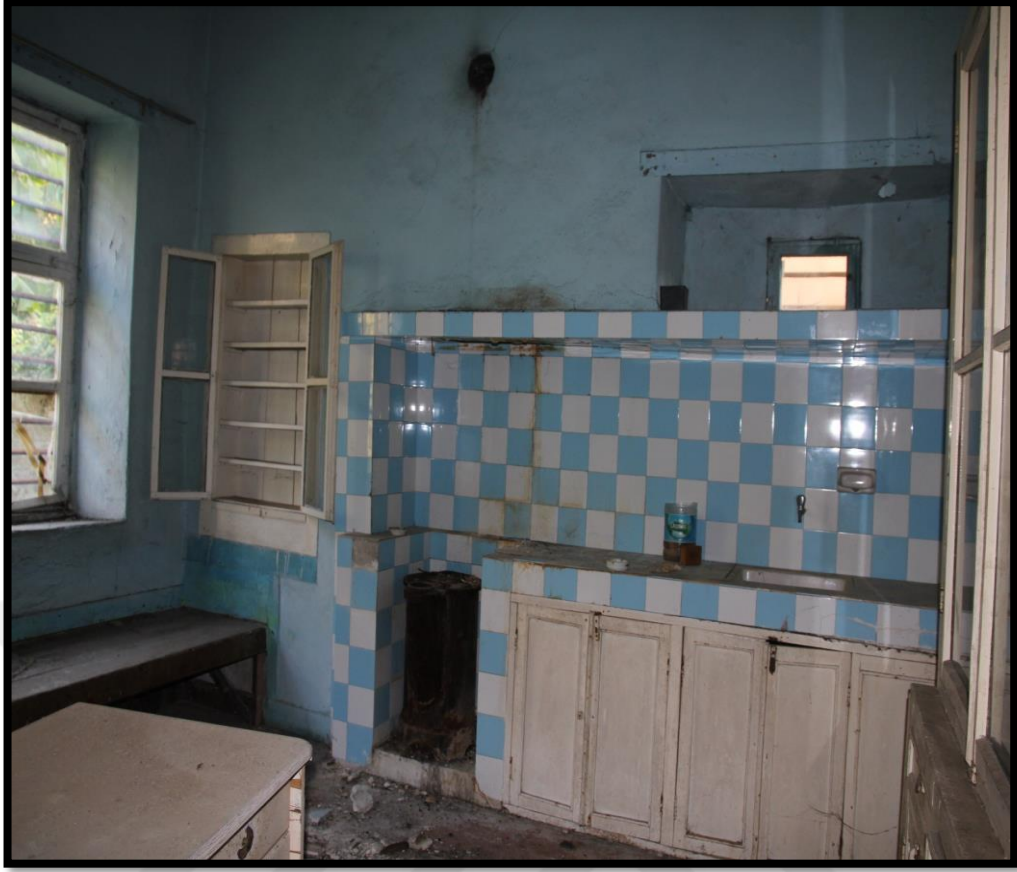
Görsel 143. Tescilli Ev 1, Birinci Kat Mutfak Görünüşü (Trabzon Rölöve ve Anıtlar Müdürlüğü Sokak Sağlıklaştırma Projesinden)
