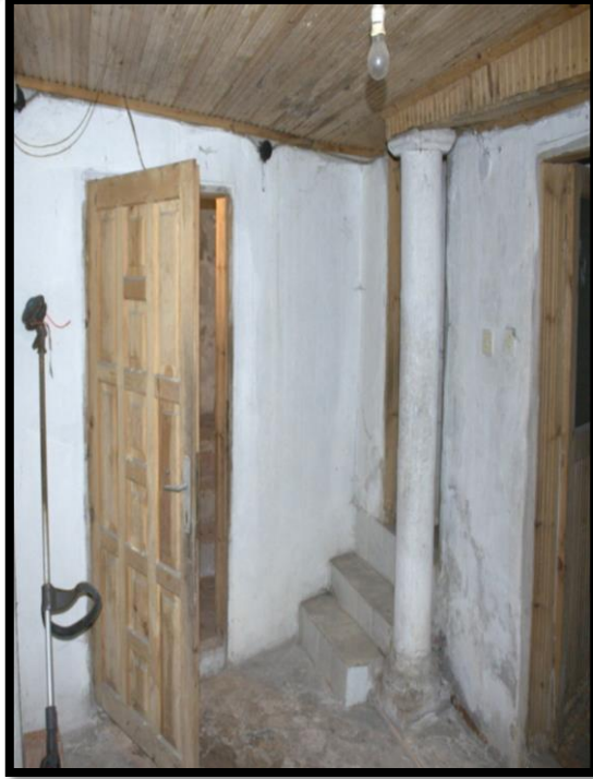
Görsel 216. Tescilli Ev 5, Bodrum Katından Görünüş (Trabzon Rölöve ve Anıtlar Müdürlüğü Sokak Sağlıklaştırma Projesinden)
