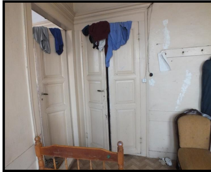
Görsel 334. Tescilli Ev 9, İkinci Kat Odalardan Görünüş (Trabzon Rölöve ve Anıtlar Müdürlüğü Sokak Sağlıklaştırma Projesinden)
