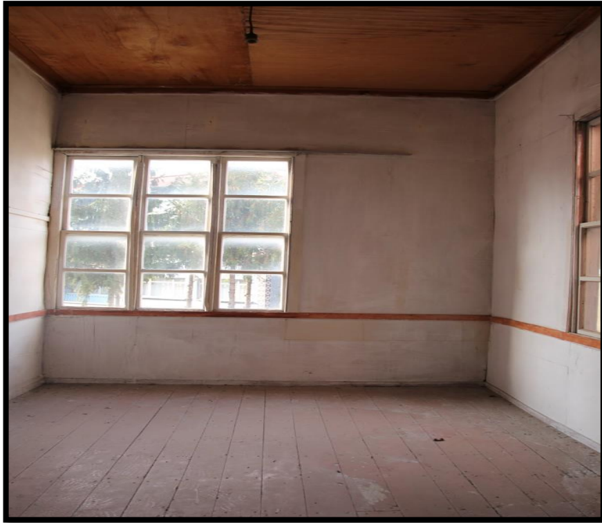
Görsel 150. Tescilli Ev 1, Birinci Kat Oda Görünüşü (Trabzon Rölöve ve Anıtlar Müdürlüğü Sokak Sağlıklaştırma Projesinden)
