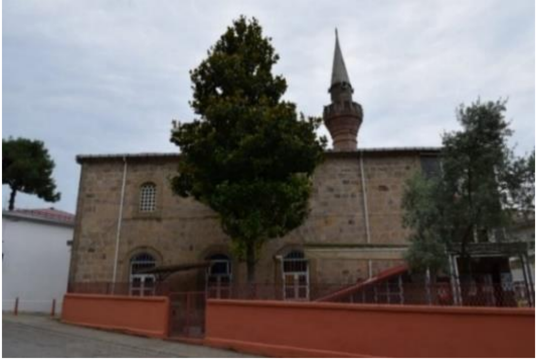
Görsel 83. Yeniköy Camii Genel Görünüm
