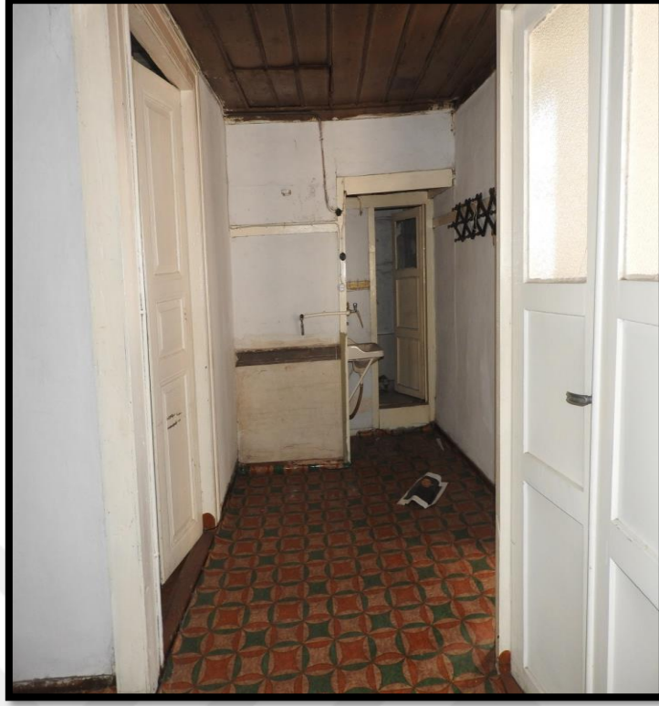
Görsel 305. Tescilli Ev 8, İkinci Kat ve Tuvalete Açılan Kapı (Trabzon Rölöve ve Anıtlar Müdürlüğü Sokak Sağlıklaştırma Projesinden)
