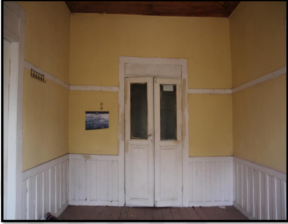
Görsel 145. Tescilli Ev 1, Birinci Kat Oda Görünüşü (Trabzon Rölöve ve Anıtlar Müdürlüğü Sokak Sağlıklaştırma Projesinden)
