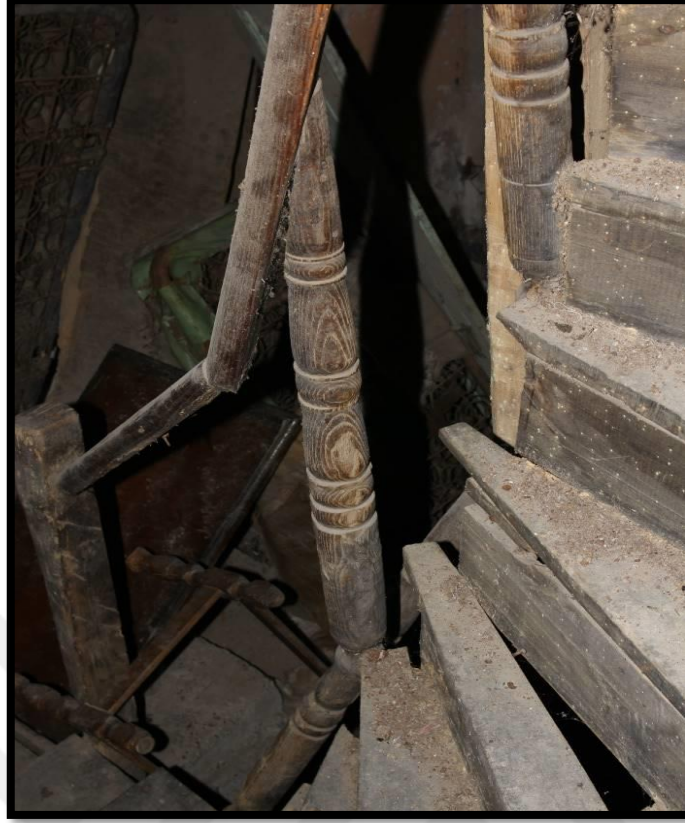
Görsel 175. Tescilli Ev 3, Zemin Katın İçten Görünüşü (Trabzon Rölöve ve Anıtlar Müdürlüğü Sokak Sağlıklaştırma Projesinden)
