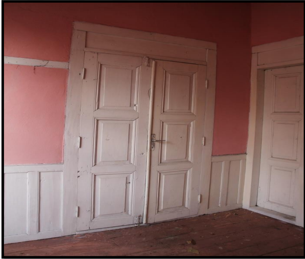
Görsel 148. Tescilli Ev 1, Birinci Kat Oda Görünüşü (Trabzon Rölöve ve Anıtlar Müdürlüğü Sokak Sağlıklaştırma Projesinden)
