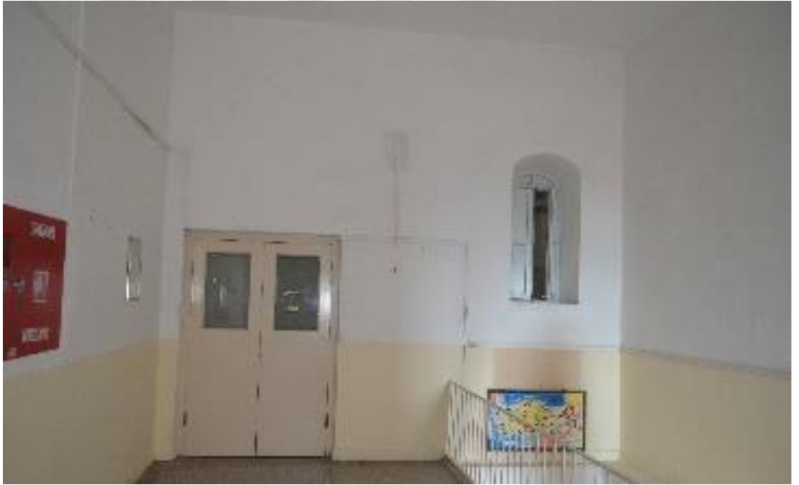
Görsel 75. Tirebolu Lisesi İkinci Katta Güney Kolda Ek Mekana Giriş Sağlayan Kapı
