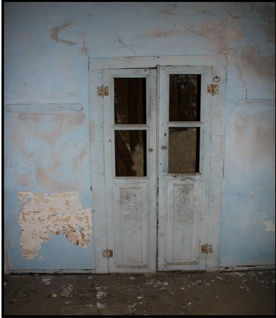
Görsel 180. Tescilli Ev 3, Birinci Kattaki Odadan Görünüş (Trabzon Rölöve ve Anıtlar Müdürlüğü Sokak Sağlıklaştırma Projesinden)
