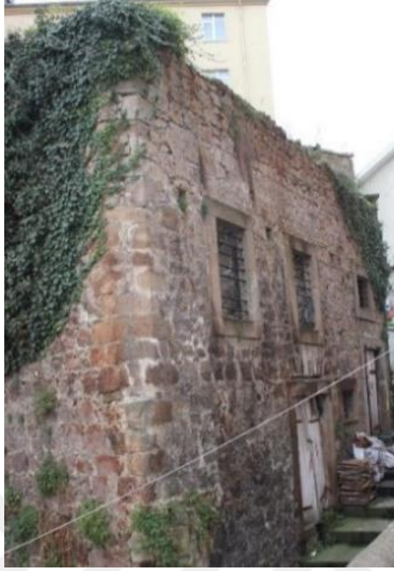
Görsel 42. Tirebolu Hamamı Müştemilatına Geçiş Sağlayan Kapı
