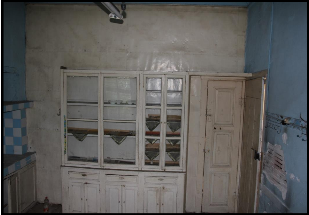
Görsel 144. Tescilli Ev 1, Birinci Kat Mutfak Görünüşü (Trabzon Rölöve ve Anıtlar Müdürlüğü Sokak Sağlıklaştırma Projesinden)
