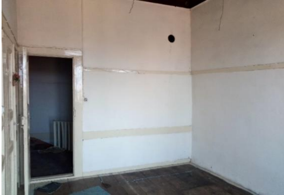
Görsel 166. Tescilli Ev 2, Duvarların Ahşap Şeritlerle Bölündüğü Örnek (Trabzon Rölöve ve Anıtlar Müdürlüğü Sokak Sağlıklaştırma Projesinden)
