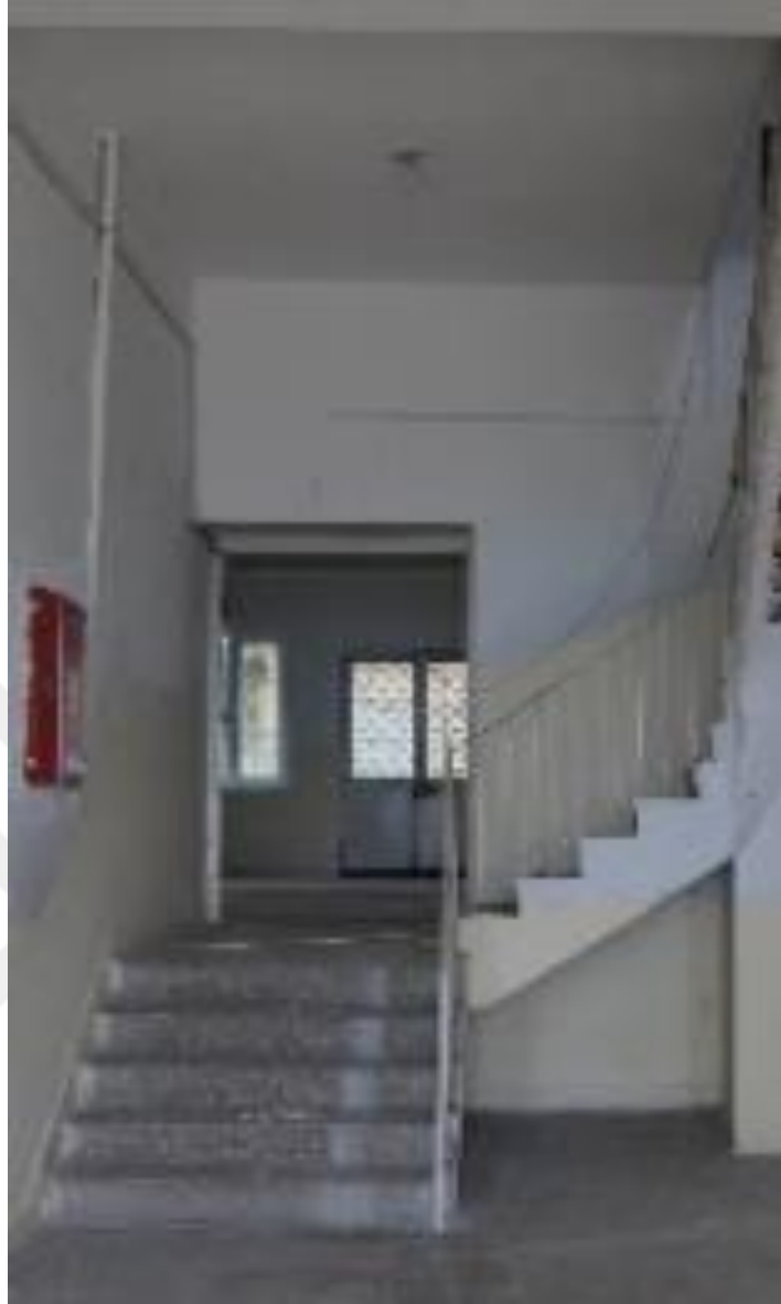
Görsel 70. Tirebolu Lisesi Güney Kolda Ek Mekana Çıkan Merdiven ve Ek Mekana Açılan Kapı
