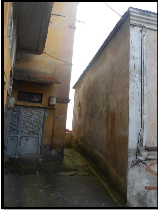
Görsel 352. Tescilli Ev 11, Güney Cephesi Görünüşü (Trabzon Rölöve ve Anıtlar Müdürlüğü Sokak Sağlığına Kavuşturma Projesinden)
