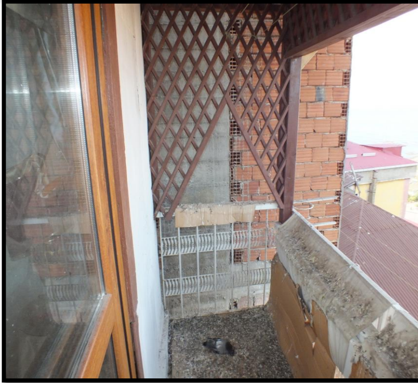
Görsel 396. Tescilli Ev 12, Birinci Kattaki Odadan Görünüş (Trabzon Rölöve ve Anıtlar Müdürlüğü Sokak Sağlıklaştırma Projesinden)
