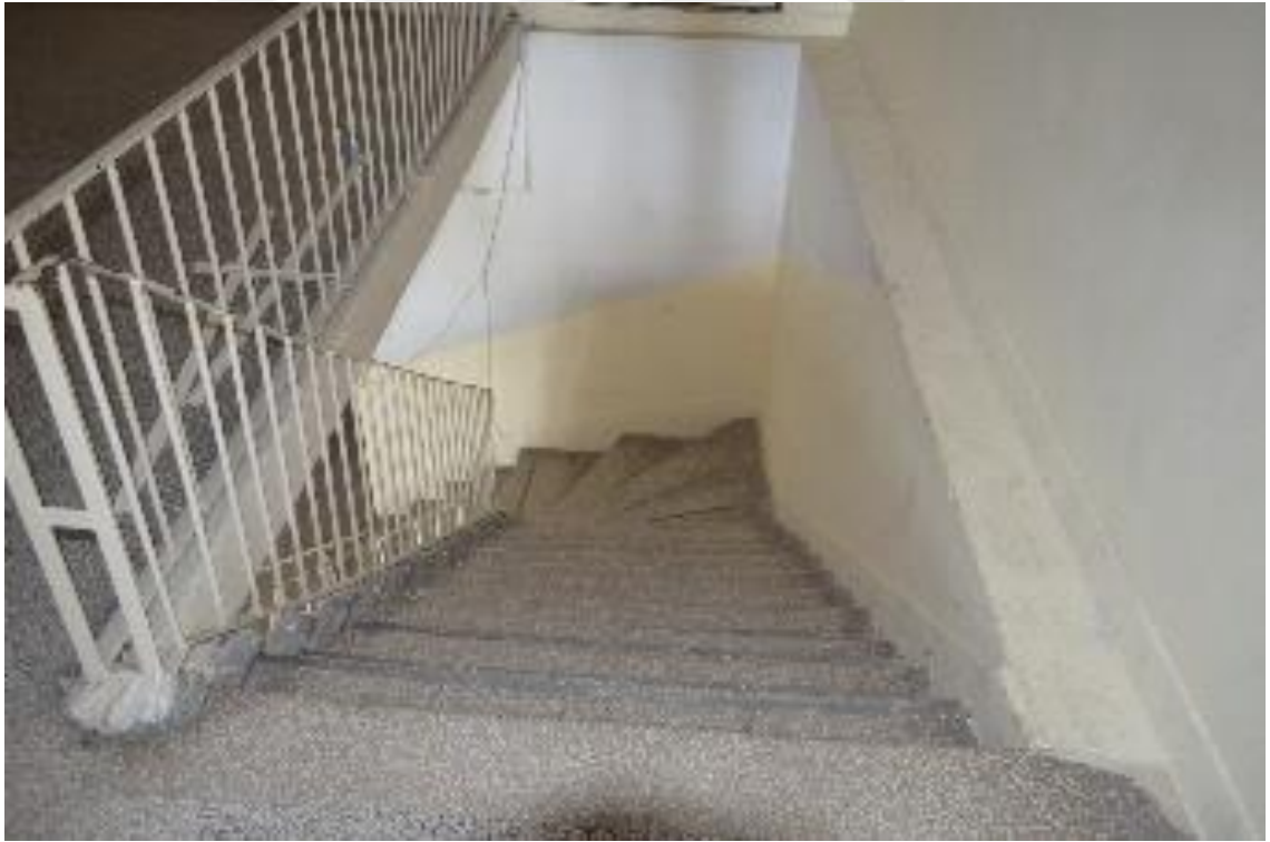
Görsel 73. Tirebolu Lisesi İkinci Kata Geçiş Sağlayan Merdiven
