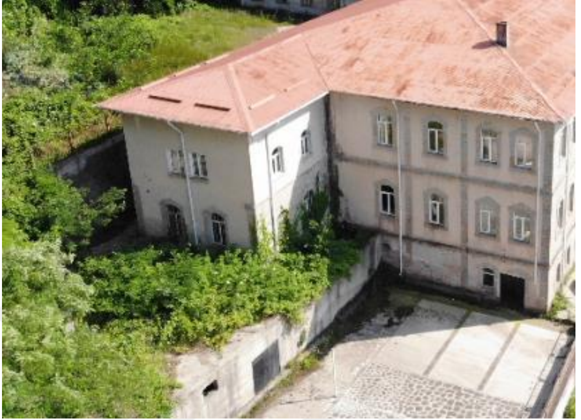
Görsel 64. Tirebolu Lisesi Doğu Cephe Genel Görünüş
