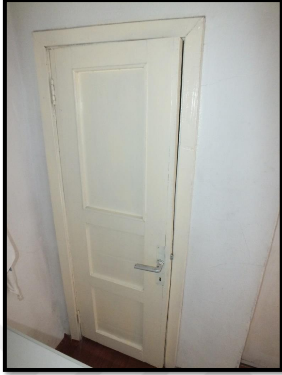
Görsel 385. Tescilli Ev 12, Zemin Kat Görünüşü (Trabzon Rölöve ve Anıtlar Müdürlüğü Sokak Sağlıklaştırma Projesinden)
