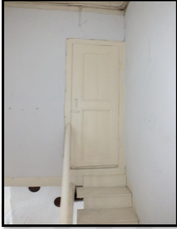
Görsel 401. Tescilli Ev 12, Birinci Kat Tuvalet Kapısı (Trabzon Rölöve ve Anıtlar Müdürlüğü Sokak Sağlıklaştırma Projesinden)
