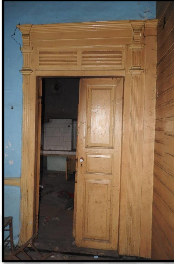
Görsel 241. Tescilli Ev 6, Zemin Kat Görünüşü (Trabzon Rölöve ve Anıtlar Müdürlüğü Sokak Sağlıklaştırma Projesinden)
