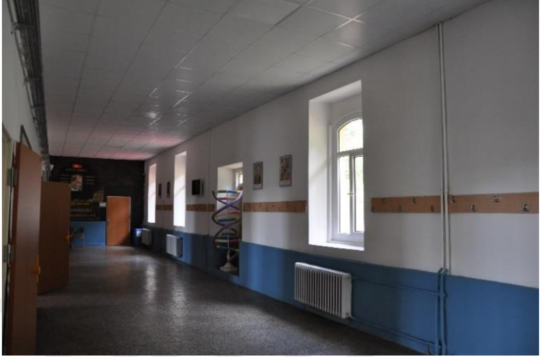
Görsel 58. Kazım Karabekir Ortaokulu Birinci Kattaki Dış Sofadan Görünüş
