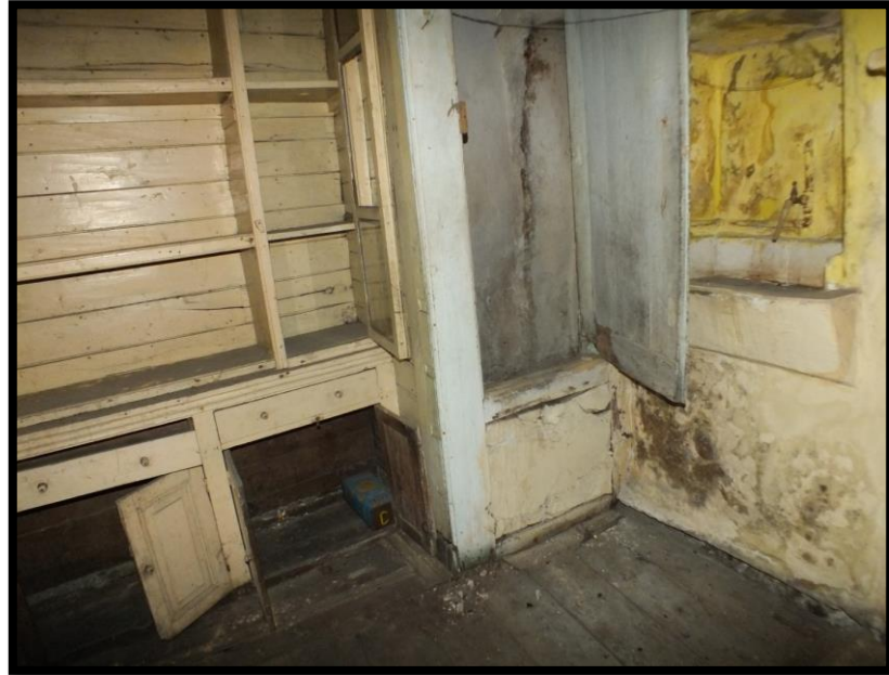
Görsel 196. Tescilli Ev 4, Birinci Kat Oda Görünüşü (Trabzon Rölöve ve Anıtlar Müdürlüğü Sokak Sağlıklaştırma Projesinden)
