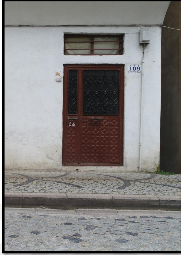
Görsel 381. Tescilli Ev 12, Zemin Kat Görünüşü (Trabzon Rölöve ve Anıtlar Müdürlüğü Sokak Sağlıklaştırma Projesinden)
