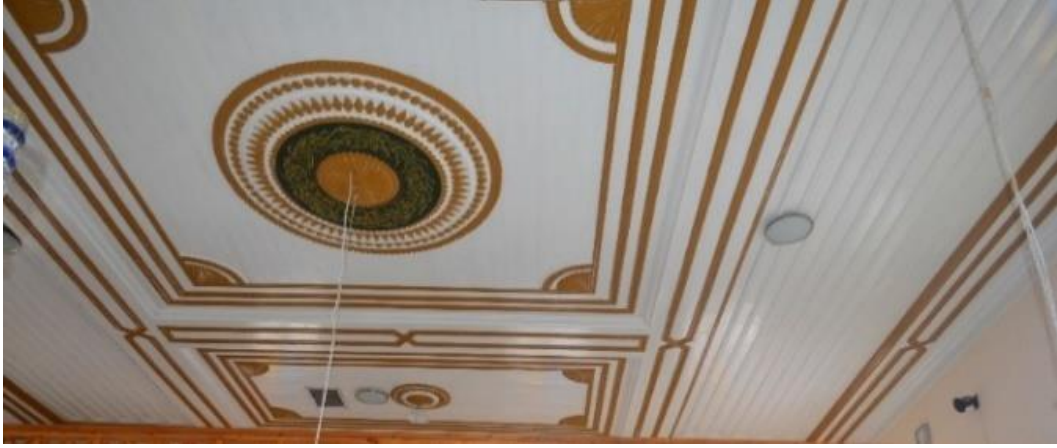
Görsel 131. Çarşı Cami Ahşap Tavan ve Süsleme Detayları
