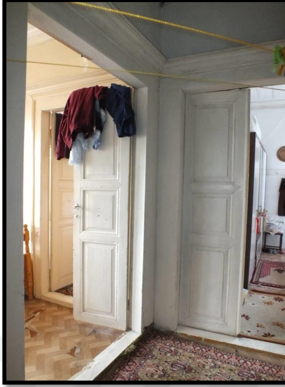
Görsel 331. Tescilli Ev 9, İkinci Kat Odalardan Görünüş (Trabzon Rölöve ve Anıtlar Müdürlüğü Sokak Sağlıklaştırma Projesinden)
