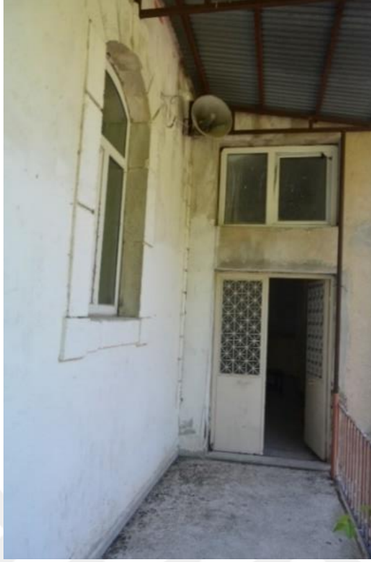
Görsel 78. Tirebolu Lisesi İkinci Kat Ek Binanın Doğu Koridorunda Bahçeye Açılan Kapı
