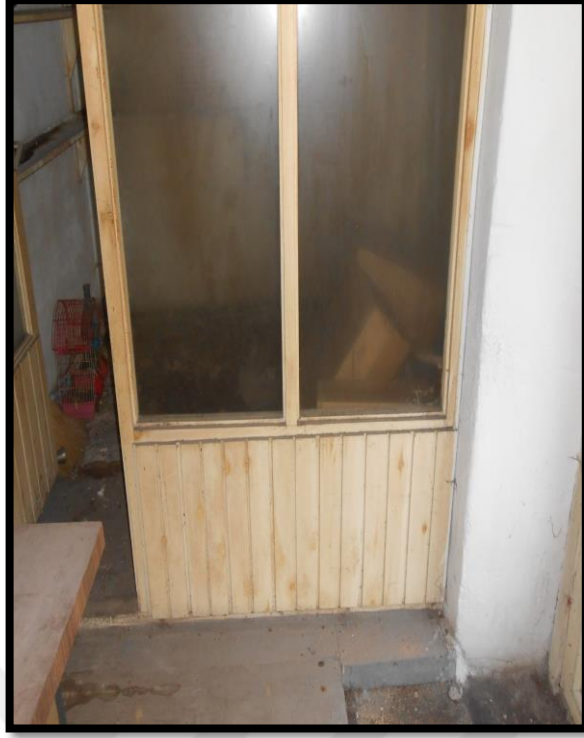
Görsel 355. Tescilli Ev 11, Yapının Zemin Katından Görünüş (Trabzon Rölöve ve Anıtlar Müdürlüğü Sokak Sağlıklaştırma Projesinden)
