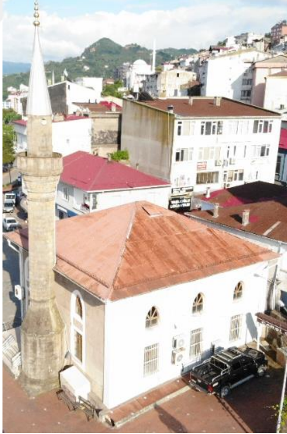
Görsel 119. Çarşı Cami Doğu Cephe Görünüşü
