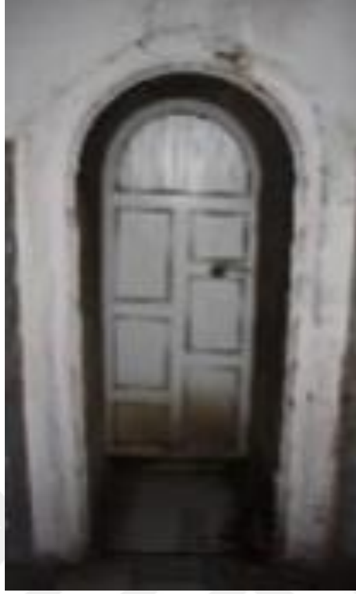
Görsel 38. Tirebolu Hamamı Sıcaklık Bölümü Giriş Kapısı
