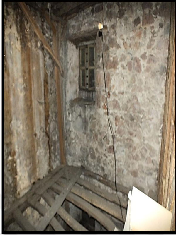
Görsel 193. Tescilli Ev 4, Zemin Kat Görünüşü (Trabzon Rölöve ve Anıtlar Müdürlüğü Sokak Sağlıklaştırma Projesinden)
