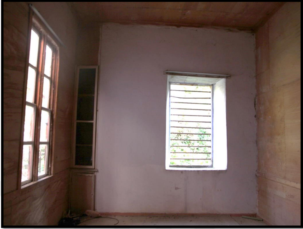
Görsel 151. Tescilli Ev 1, Birinci Kat Oda Görünüşü (Trabzon Rölöve ve Anıtlar Müdürlüğü Sokak Sağlıklaştırma Projesinden)
