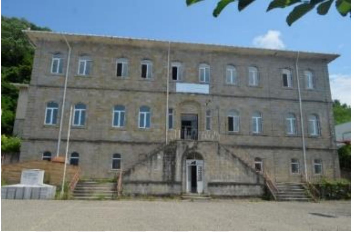
Görsel 60. Tirebolu Lisesi Kuzey Cephe Genel Görünüşü
