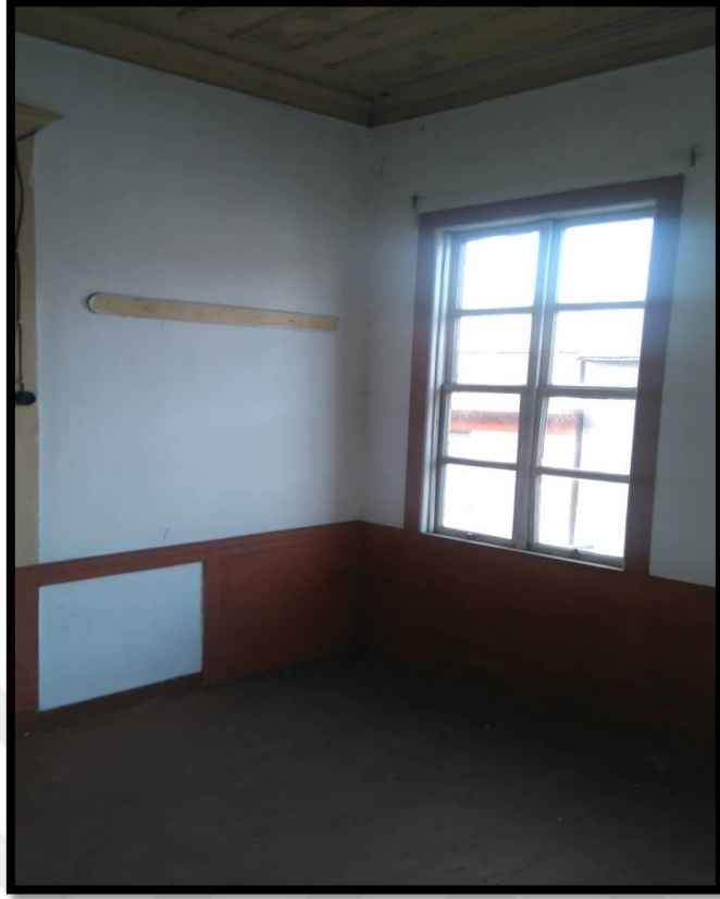
Görsel 371. Tescilli Ev 11, İkinci Katın Odasından Görünüş (Trabzon Rölöve ve Anıtlar Müdürlüğü Sokak Sağıklaştırma Projesinden)
