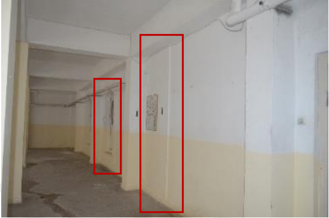
Görsel 62. Tirebolu Lisesi Asıl Güney Cephe Olduğu Düşünülen Kısım, Pencere ve Pilastr Detayları
