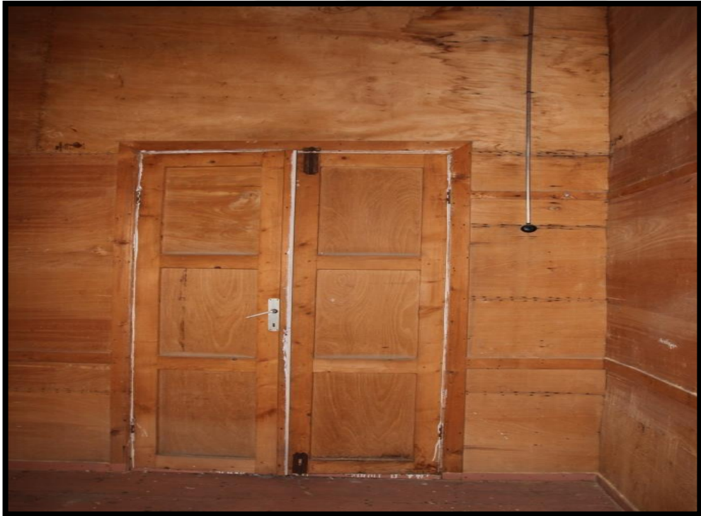
Görsel 152. Tescilli Ev 1, Birinci Kat Oda Görünüşü (Trabzon Rölöve ve Anıtlar Müdürlüğü Sokak Sağlıklaştırma Projesinden)
