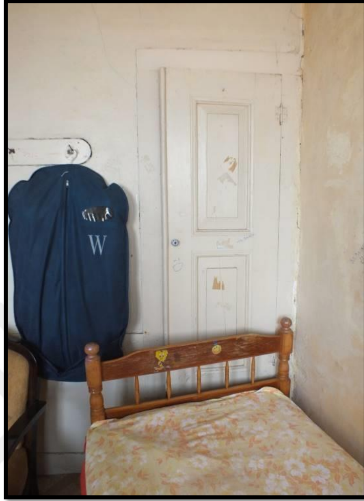
Görsel 333. Tescilli Ev 9, İkinci Kat Odalardan Görünüş (Trabzon Rölöve ve Anıtlar Müdürlüğü Sokak Sağlıklaştırma Projesinden)
