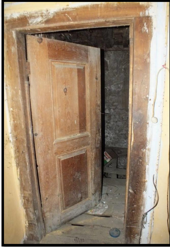
Görsel 192. Tescilli Ev 4, Zemin Kat Görünüşü (Trabzon Rölöve ve Anıtlar Müdürlüğü Sokak Sağlıklaştırma Projesinden)
