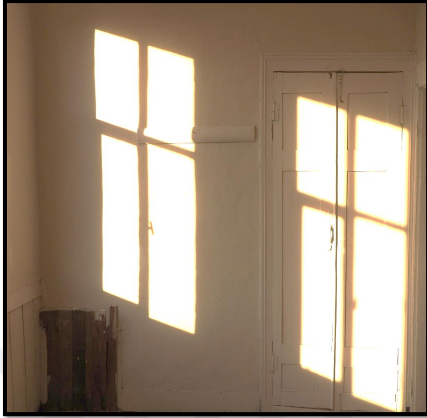
Görsel 297. Tescilli Ev 8, Birinci Kat Odadan Görünüş (Trabzon Rölöve ve Anıtlar Müdürlüğü Sokak Sağlıklaştırma Projesinden)
