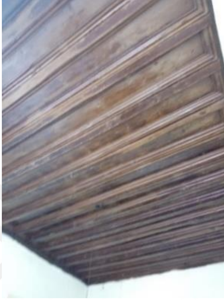
Görsel 165. Tescilli Ev 2, Ahşap Tavan ve Zemin Örneği (Trabzon Rölöve ve Anıtlar Müdürlüğü Sokak Sağlıklaştırma Projesinden)
