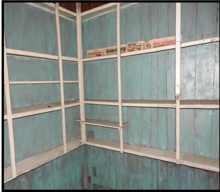
Görsel 238. Tescilli Ev 6, Zemin Kat Dükkân Görünüşü (Trabzon Rölöve ve Anıtlar Müdürlüğü Sokak Sağlıklaştırma Projesinden)
