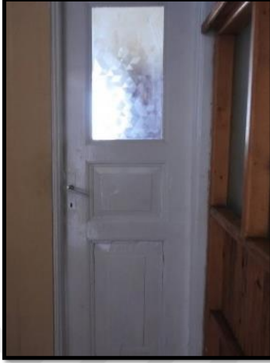
Görsel 419. Tescilli Ev 13, İkinci Kat Odadan Görünüş (Trabzon Rölöve ve Anıtlar Müdürlüğü Sokak Sağlıklaştırma Projesinden)
