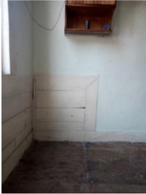
Görsel 168. Tescilli Ev 2, Pencere Altlarında Ve Alt Seviyede Devam Eden Ahşap Şeritler (Trabzon Rölöve ve Anıtlar Müdürlüğü Sokak Sağıklaştırma Projesinden)
