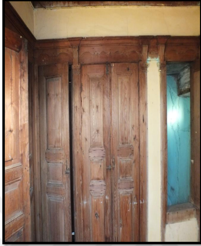
Görsel 203. Tescilli Ev 4, İkinci Kat Oda Görünüşü (Trabzon Rölöve ve Anıtlar Müdürlüğü Sokak Sağlıklaştırma Projesinden)
