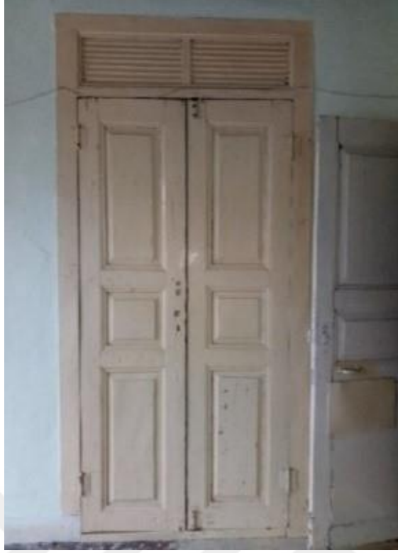
Görsel 163. Tescilli Ev 2, Birinci Kat Ahşap Kapı Tipleri (Trabzon Rölöve ve Anıtlar Müdürlüğü Sokak Sağlıklaştırma Projesinden)
