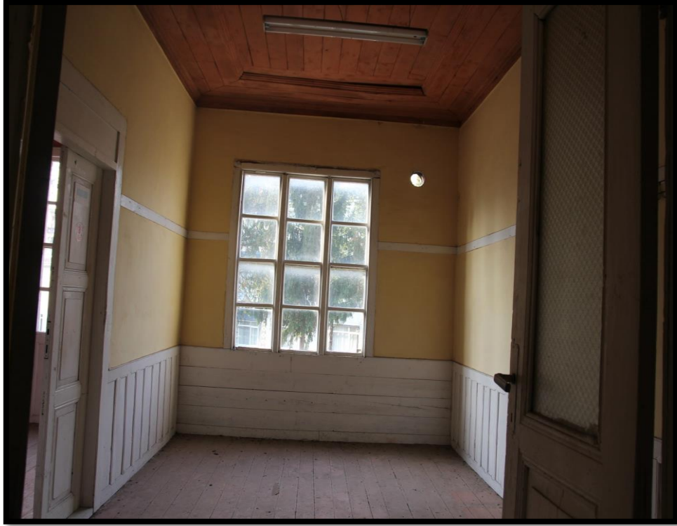
Görsel 146. Tescilli Ev 1, Birinci Kat Oda Görünüşü (Trabzon Rölöve ve Anıtlar Müdürlüğü Sokak Sağlıklaştırma Projesinden)
