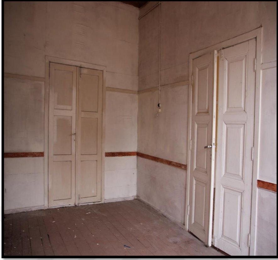
Görsel 149. Tescilli Ev 1, Birinci Kat Oda Görünüşü (Trabzon Rölöve ve Anıtlar Müdürlüğü Sokak Sağlıklaştırma Projesinden)
