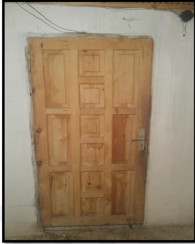
Görsel 213. Tescilli Ev 5, Bodrum Katından Görünüş (Trabzon Rölöve ve Anıtlar Müdürlüğü Sokak Sağlıklaştırma Projesinden)
