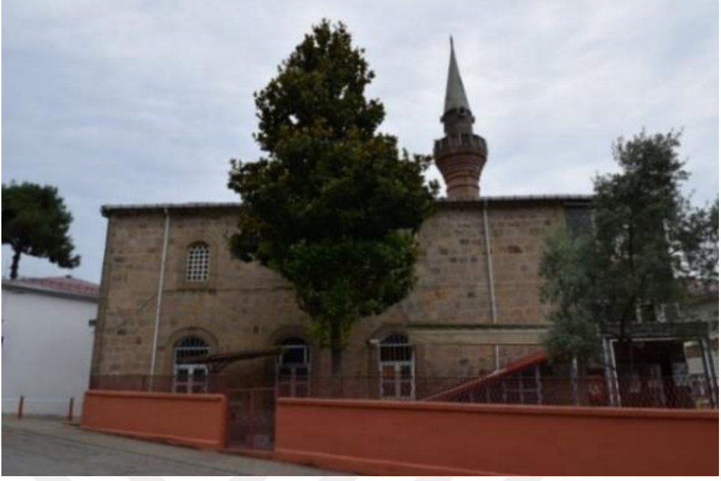
Görsel 92. Yeniköy Cami Batı Cephe Genel Görünüm
