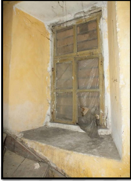
Görsel 191. Tescilli Ev 4, Zemin Kat Görünüşü (Trabzon Rölöve ve Anıtlar Müdürlüğü Sokak Sağlıklaştırma Projesinden)
