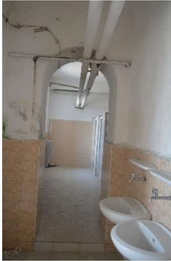
Görsel 67. Tirebolu Lisesi Zemin Kattaki Dar Kemerli Kapı Açıklığı
