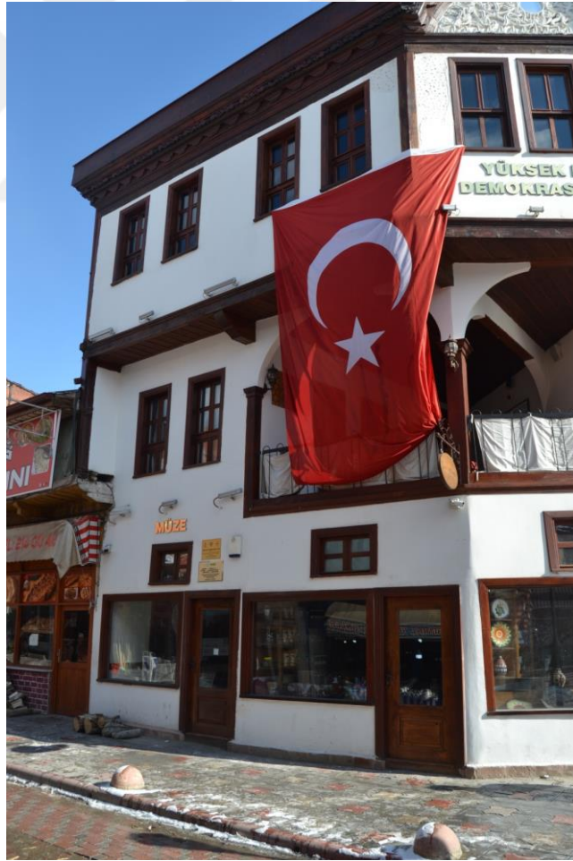
Görsel 85: Yüksek Kahve Binası Güneybatı Cephe Görünümü
