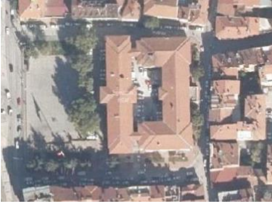
Görsel 45: Tokat Valilik Binası Görünümü (Tapu ve Kadastro Genel Müdürlüğü)
