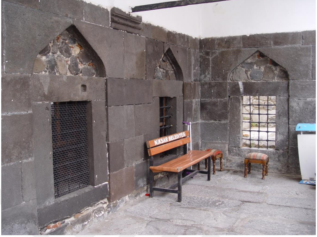
Görsel 111: Niksar Taş Mektep Binası Giriş Kısımında Sağda Yer Alan Pencere
