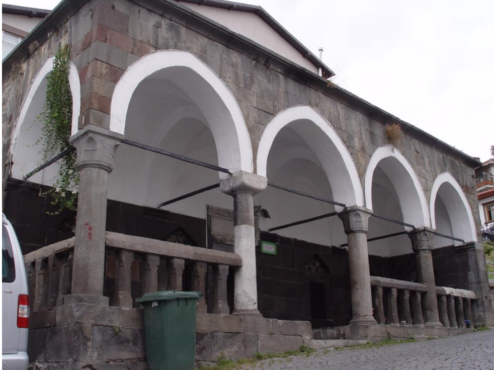
Görsel 104: Niksar Taş Mektep Binası Ön Cephe
