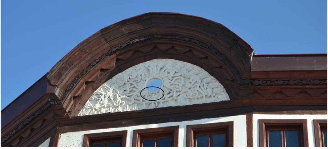
Görsel 55: Yüksek Kahve Binası Güney Cephede Yer Alan Yarım Daire Formundaki Süslemeli Alınlık Kısmı
