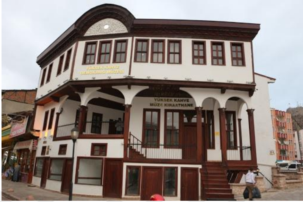
Görsel 84: Yüksek Kahve Binası Ön Cephe Görünümü
