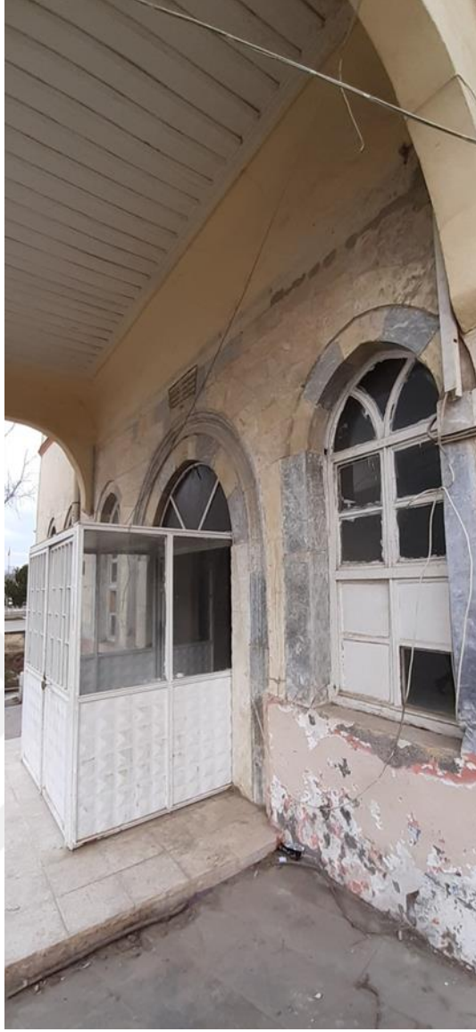
Görsel 119: Pazar Eski Hükümet Konağı Giriş Kapısı
