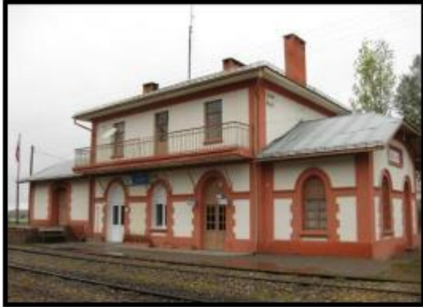
Görsel 150: Sivas Kalmın Tren İstasyon Binası Ön Cephe (H. Ş. Haştemoğlu'nun Demiryolu İstasyon Binalarına Yeni Fonksiyon Önerileri Geliştirilmesi Adlı Doktora Tezinden)
