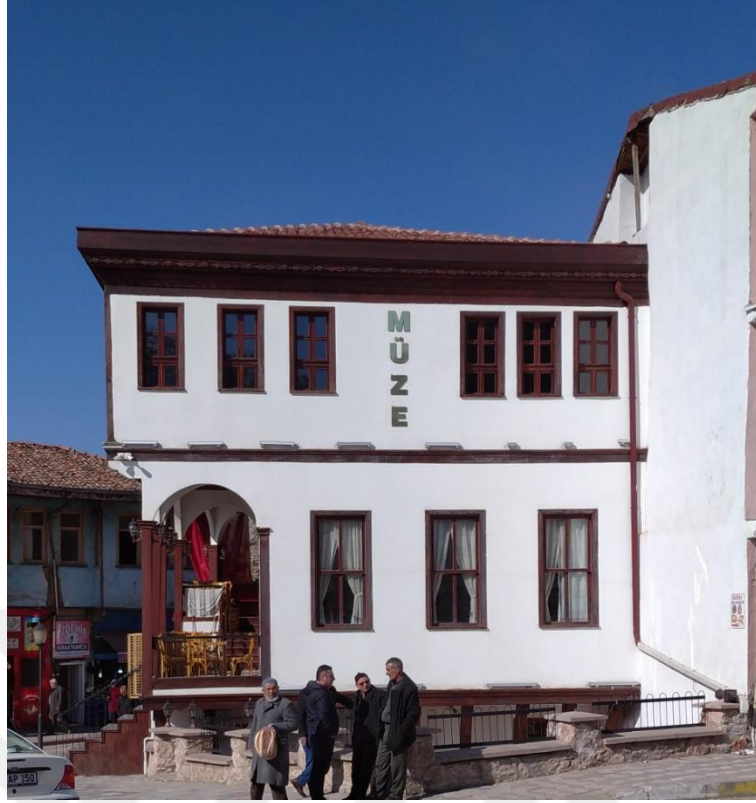
Görsel 86: Yüksek Kahve Binası Doğu Cephe Görünümü
