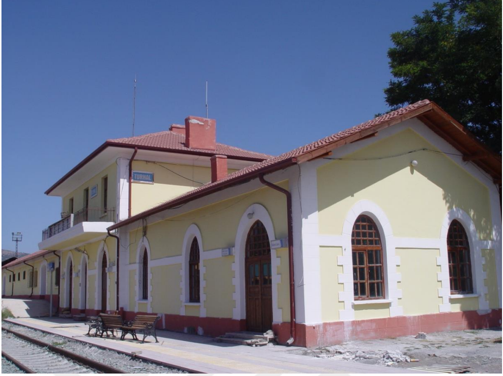
Görsel 140: Turhal Tren İstasyon Binası Sağda Yer Alan Bekleme Salonu
