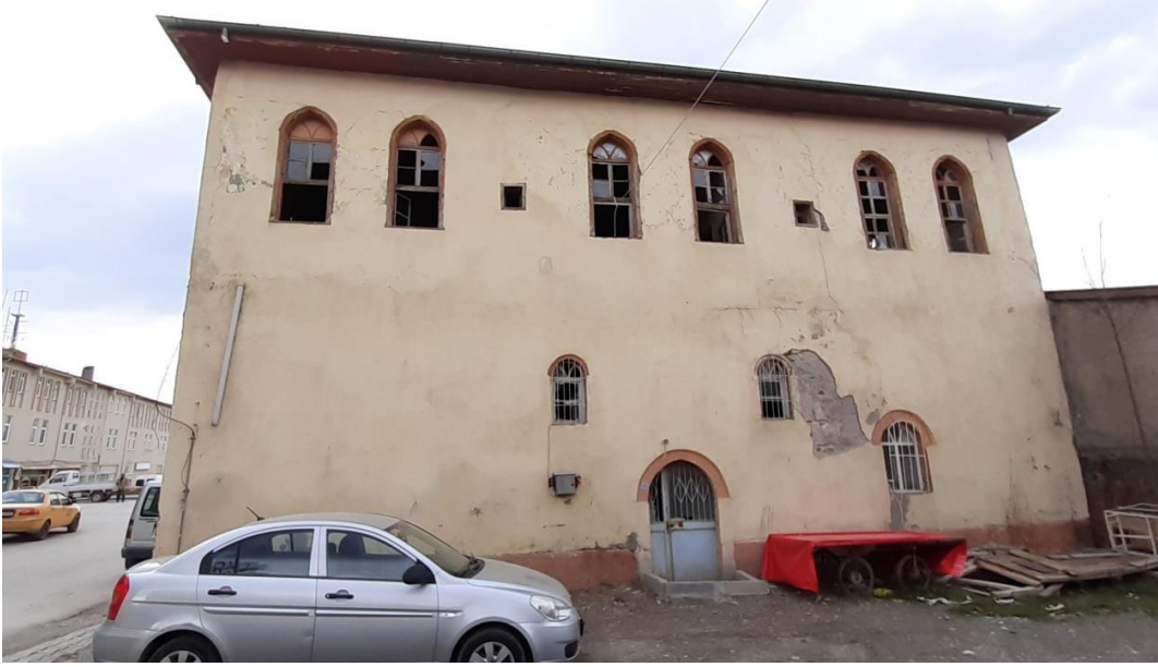
Görse 124: Pazar Eski Hükümet Konağı Arka Cephe Görünümü
