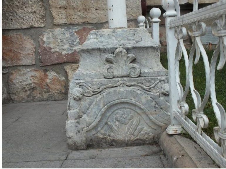
Görsel 41: Tokat Belediye Binası Girişi Önünde Yer Alan Bayrak Direği Kaidesi
