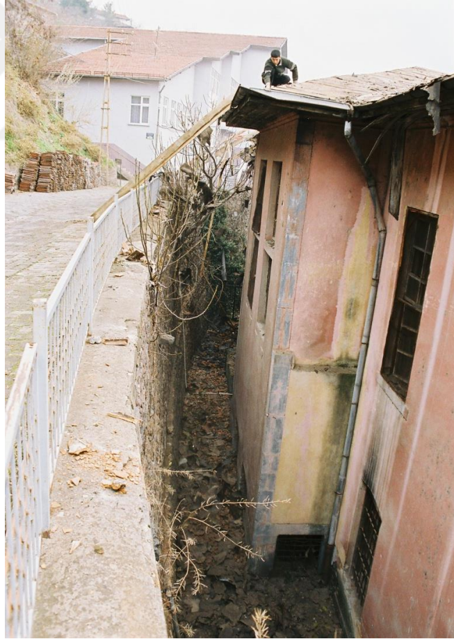
Görsel 99: Niksar Hükümet Konağı Kuzey (arka) Cephe (Niksar Belediyesi)
