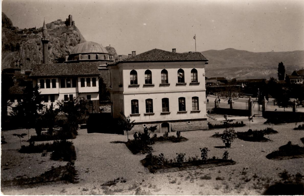
Görsel 6: Tokat Belediye Binası Bodrum Katın Orijinal Görünümü (Hasan Erdem Arşivi)
