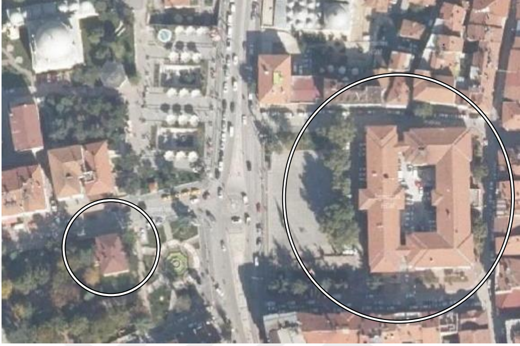
Görsel 1: Solda Tokat Belediye Binası/ Sağda Tokat Valilik Binası Görünümü (Tapu ve Kadastro Genel Müdürlüğü)
