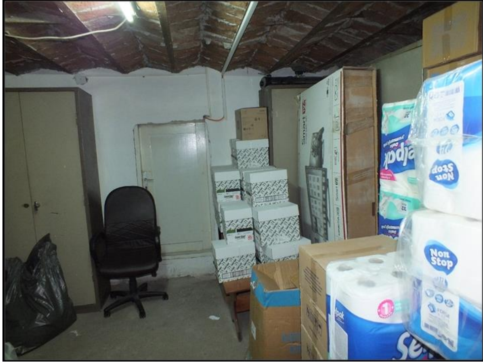
Görsel 22: Tokat Belediye Binası Bodrum Kat Güneydeki Oda ve Volta Tavan Uygulaması
