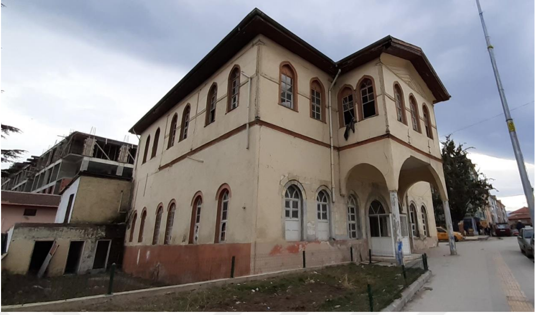
Görse 123: Pazar Eski Hükümet Konağı Sol Yan Cephe Görünümü
