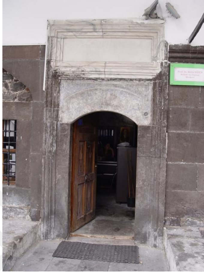
Görsel 105: Niksar Taş Mektep Binası Basık Kemerli Giriş Kapısı
