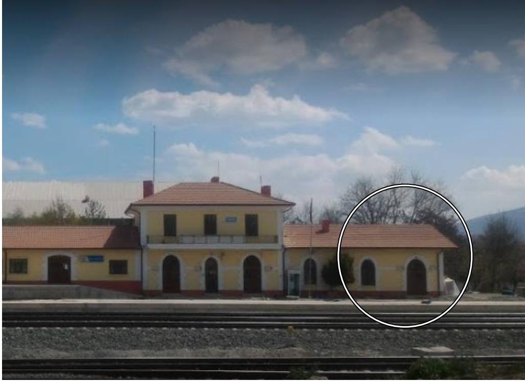
Görsel 135: Turhal Tren İstasyon Binası Sonradan Eklenen Kısmı
