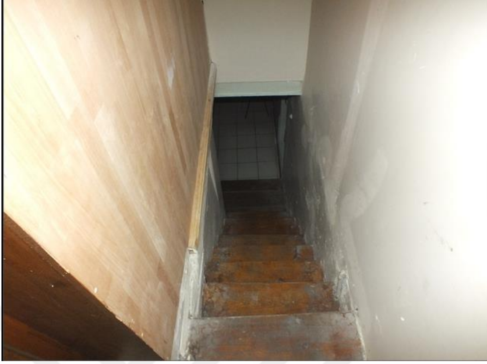
Görsel 19: Tokat Belediye Binası Bodrum Kata İniş Saęlayan Merdiven
