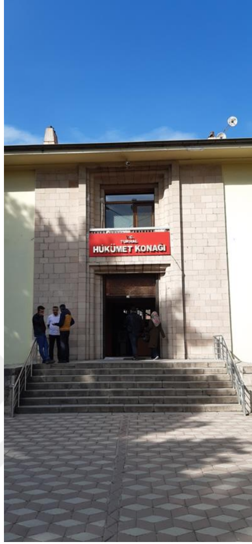
Görself 127: Turhal Hükümet Konağı Güney Giriş Cephesi
