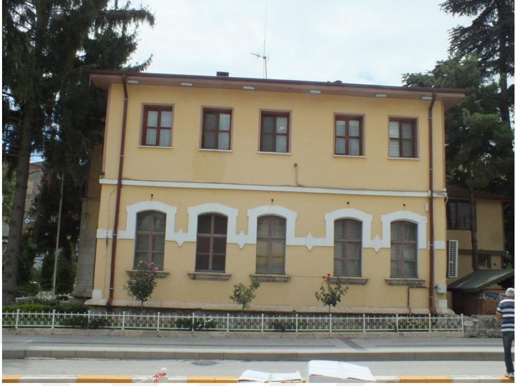
Görsel 37: Tokat Belediye Binası Kuzey Cephe Genel Görünümü
