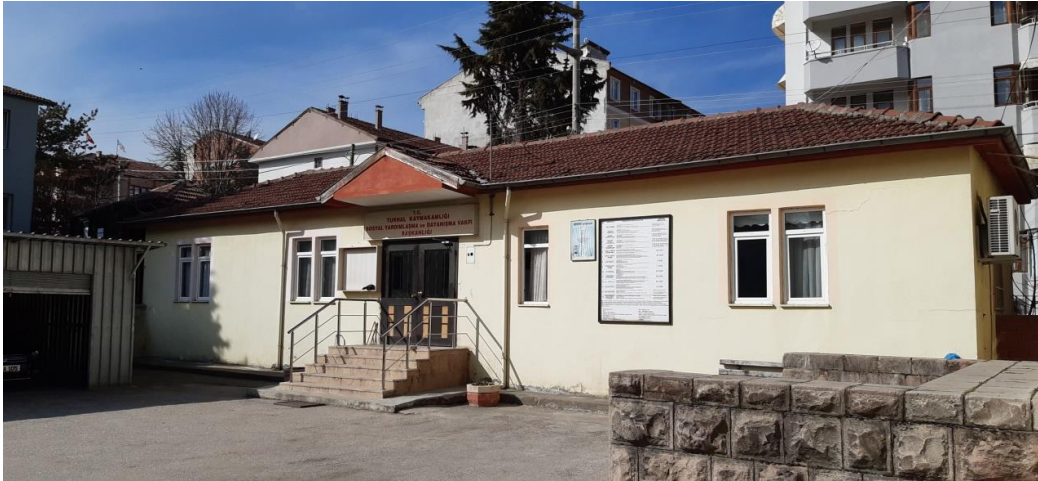
Görse 131: Turhal Hükümet Konağı Batısında Yer Alan Sosyal Yardımlaşma ve Dayanışma Vakfı Başkanlığı Binası
