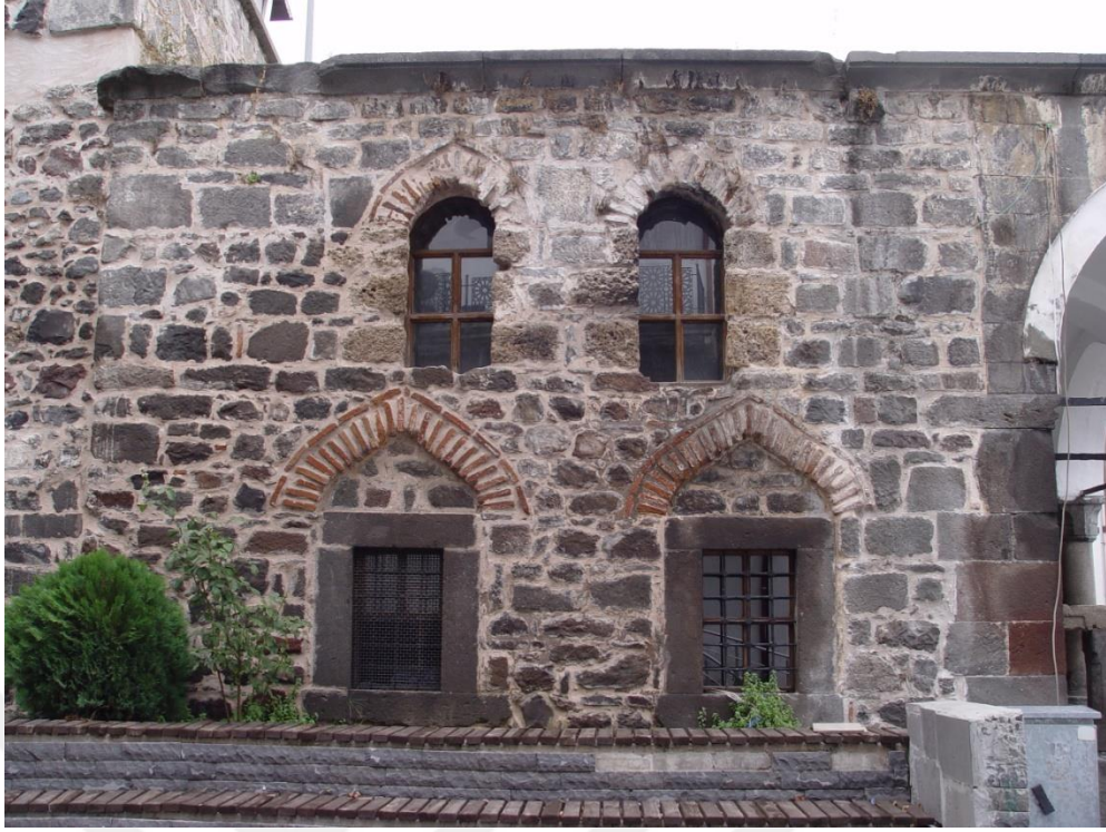
Görsel 109: Niksar Taş Mektep Binası Batı Cephe
