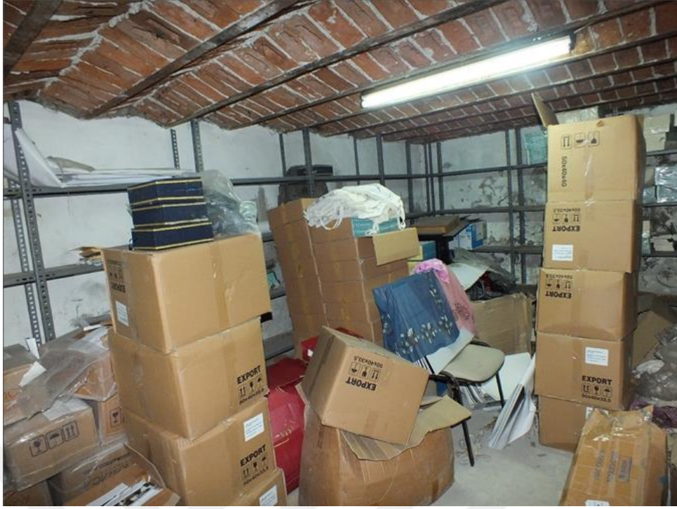
Görsel 21: Tokat Belediye Binası Bodrum Kat Güneydeki Oda ve Volta Tavan Uygulaması
