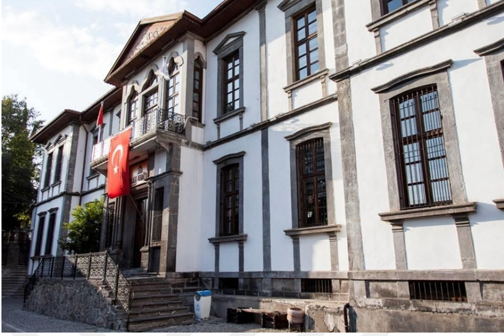
Görsel 98: Niksar Hükümet Konağı Güney Cepheye Bakış (Niksar Belediyesi)
