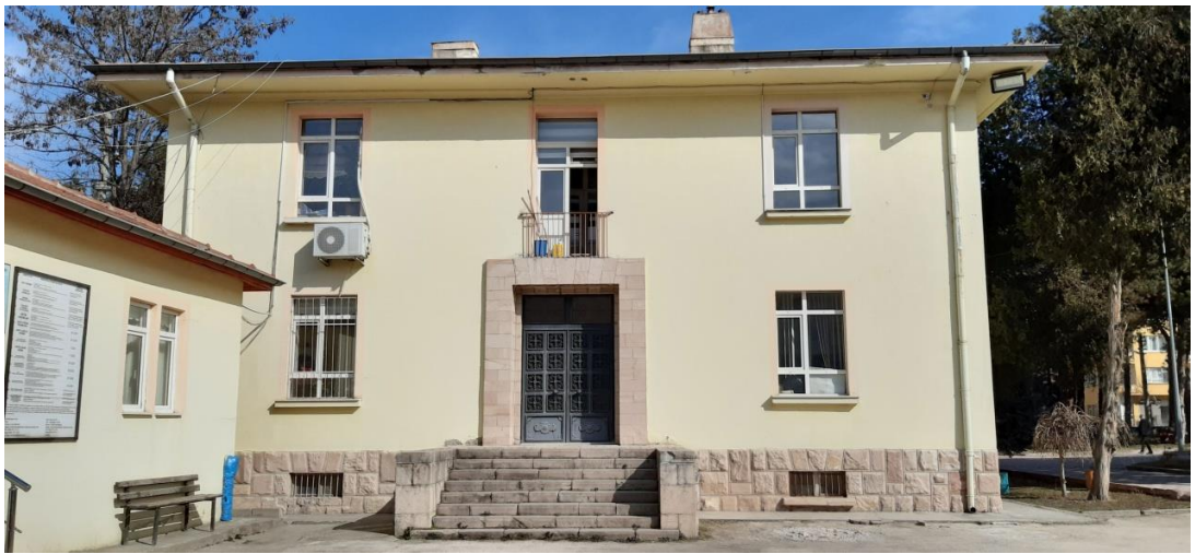
Görself 128: Turhal Hükümet Konağı Batı Cephesi
