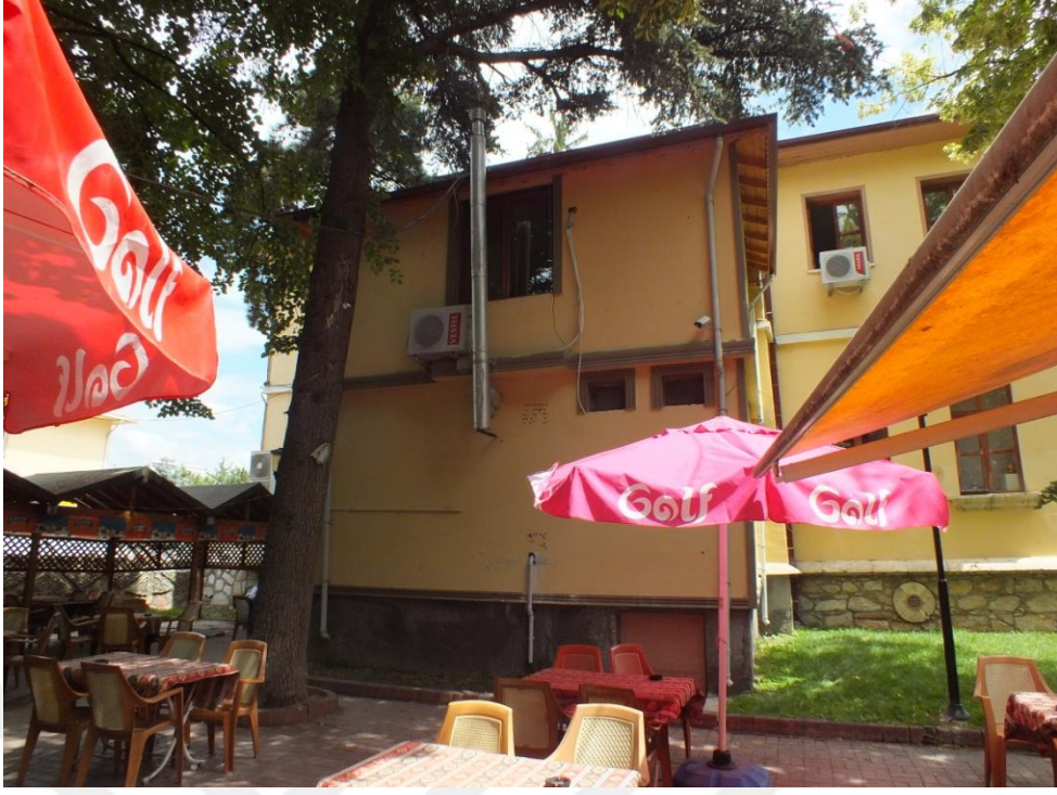
Görsel 35: Tokat Belediye Binası Arka (batı) Cephesi
