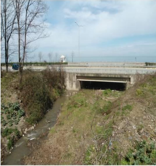
Keşap Giriş Köprüsü
