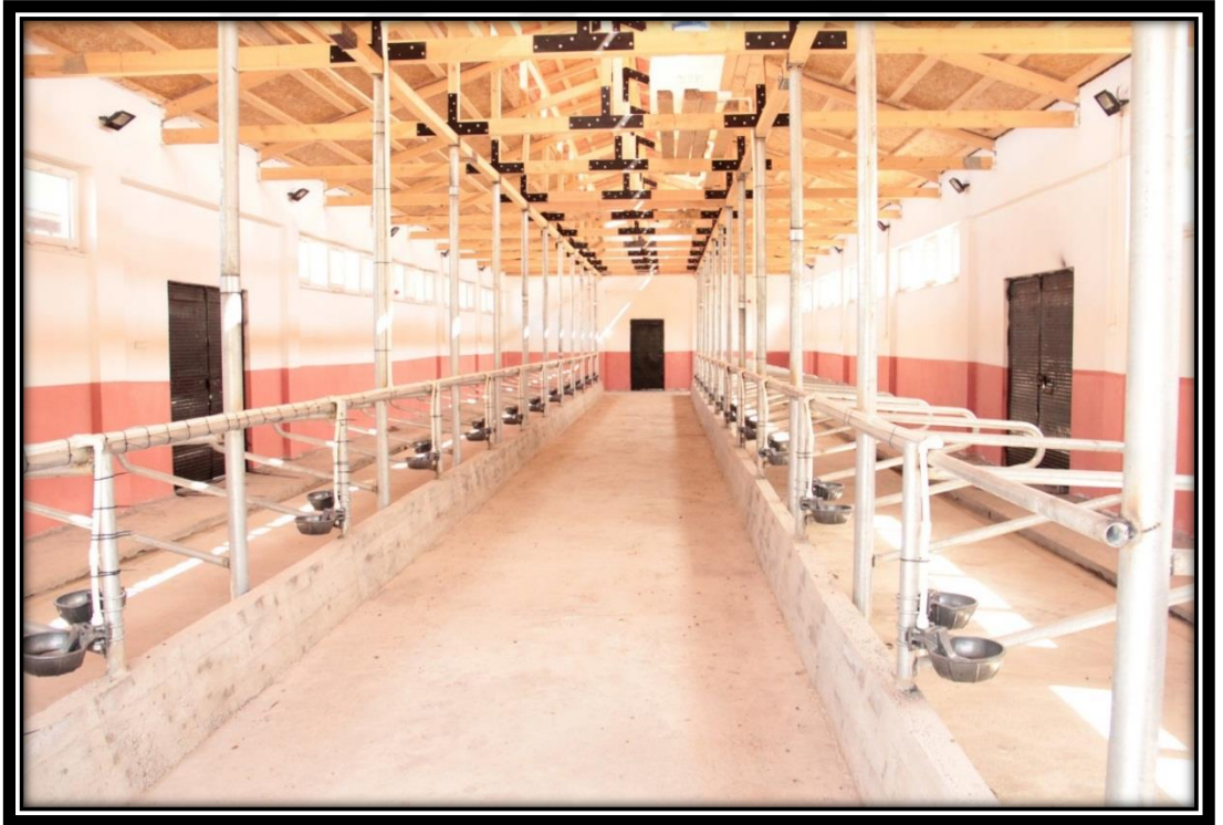
Şekil 4.4. Müstakil bağlı duraklı ahır ( İç görünüş )
