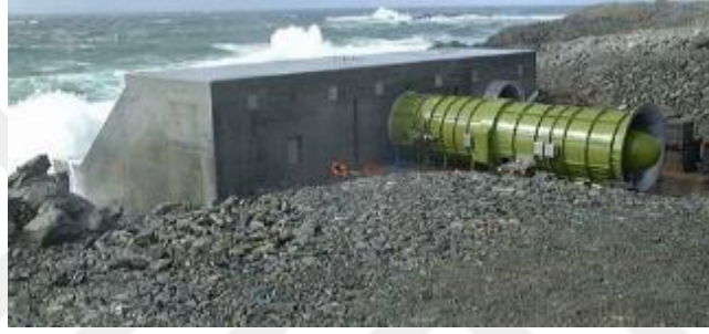
Şekil 2.1 LIMPET Genel Görünüm
