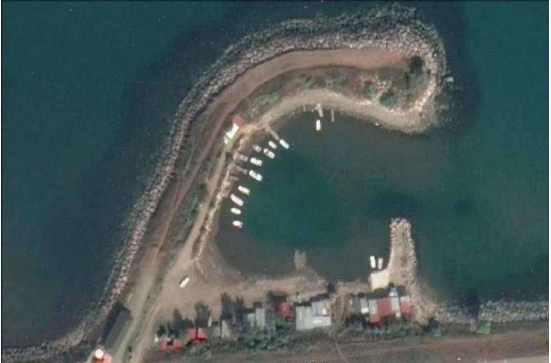
Şekil 4.28 İncüvez Çekkek Yeri Uydu Görüntüsü (Google Earth)
