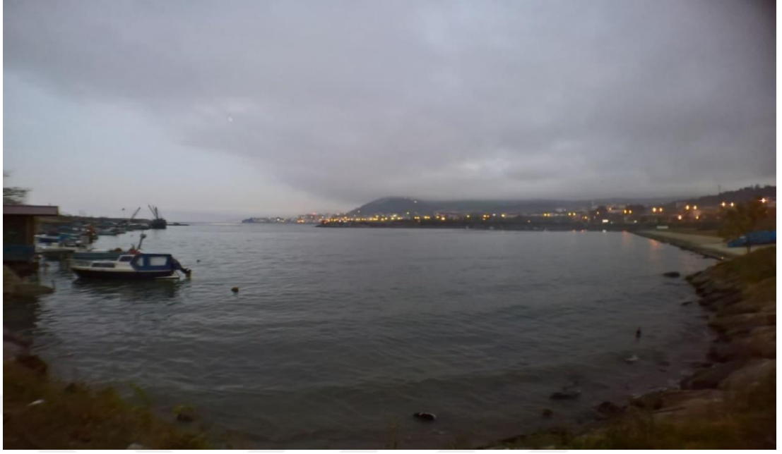
Şekil 4.49 Piraziz Barınma Yeri Genel Görünüş
