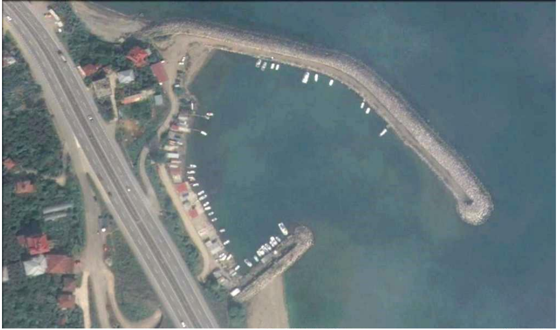
Şekil 4.44 Yalıköy Çekkek Yeri Uydu Görüntüsü (Google Earth)
