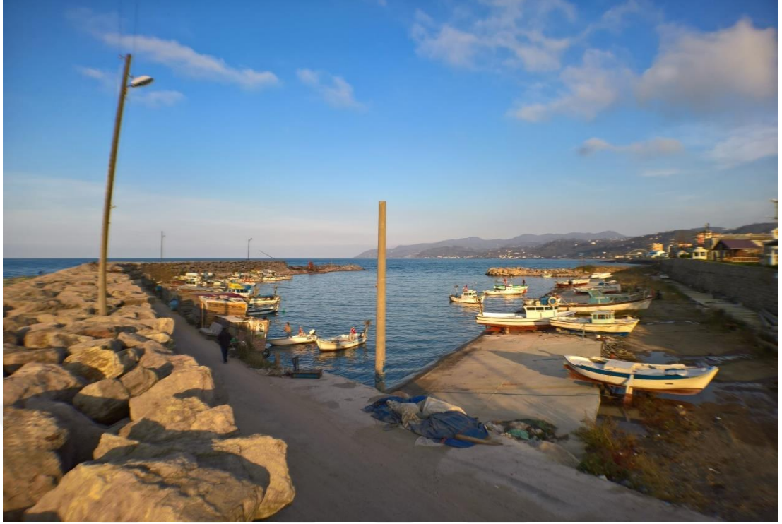
Şekil 4.31 Keşap Çekkek Yeri Genel Görünüş
