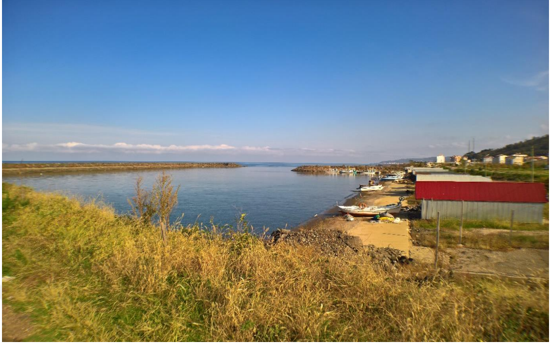
Şekil 4.23 Görele Çavuşlu Çekek Yeri Genel Görünüş
