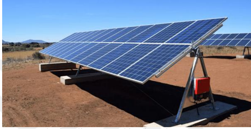
Şekil 3.2 Tek Eksenli Güneş Takip Sistemi
