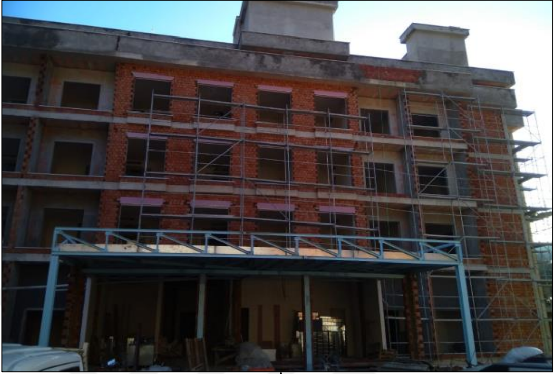
Şekil 4.2.a Sarmaşık Kaplıca Termal Otel İnşaatı
