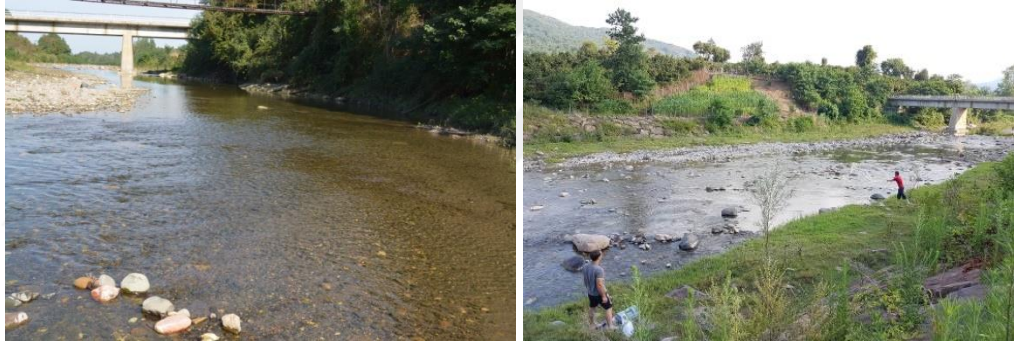
Şekil 3.1.6 Göbü Mahallesi istasyonunun genel görünüşü
