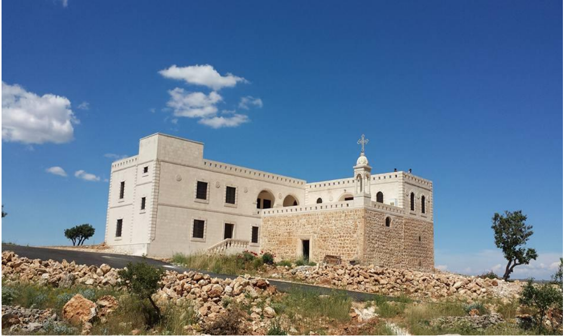
Şekil 13/b: Kafro CElayto (Arıca) Köyünde yer alan Mor Aho Manastırı'nın restorasyon sonrası genel bir görünümü. (Fotoğraf: İsa TEMİZ)
