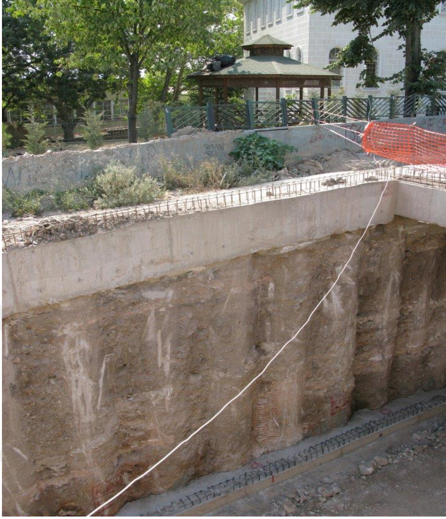
Şekil 4. 9 Yol çalışması sırasında bulunan Roma Dönemi'ne ait duvar
