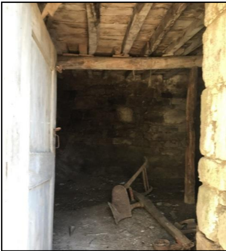
Şekil 2. 31. Ahır mekanından döşeme strüktür örneği (Asan, 2017)
