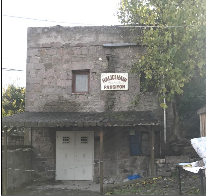
Şekil 3. 32. Cephede lekelenme ile bozulma örneği (Asan, 2019)
