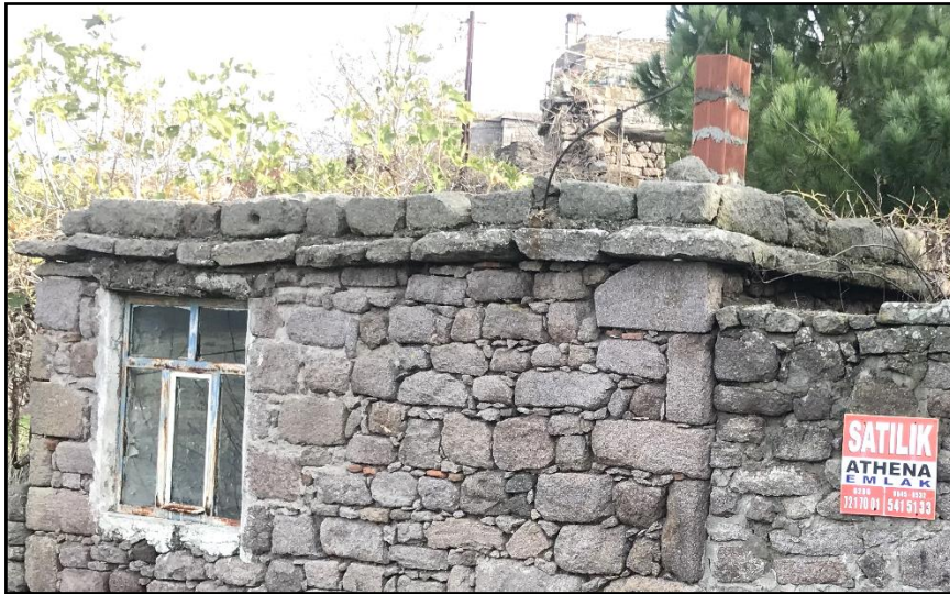
Şekil 3. 31. Taştaki çürüme bozulma örneği (Asan, 2019)
