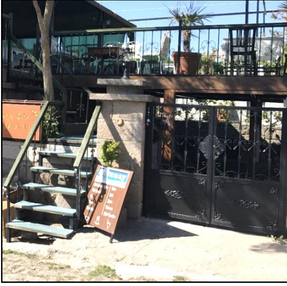
Şekil 3. 8. Yapılara sonradan eklenen ferforjeler (Asan, 2017)
