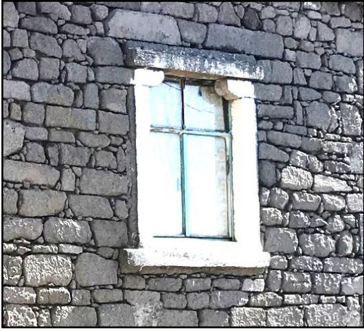
Şekil 2. 22. Taş söveli karakteristik pencere örneği (Asan, 2018)
