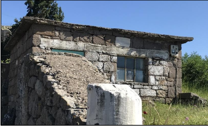
Şekil 2. 19. Köydeki türbe yapısı (Asan, 2018)
