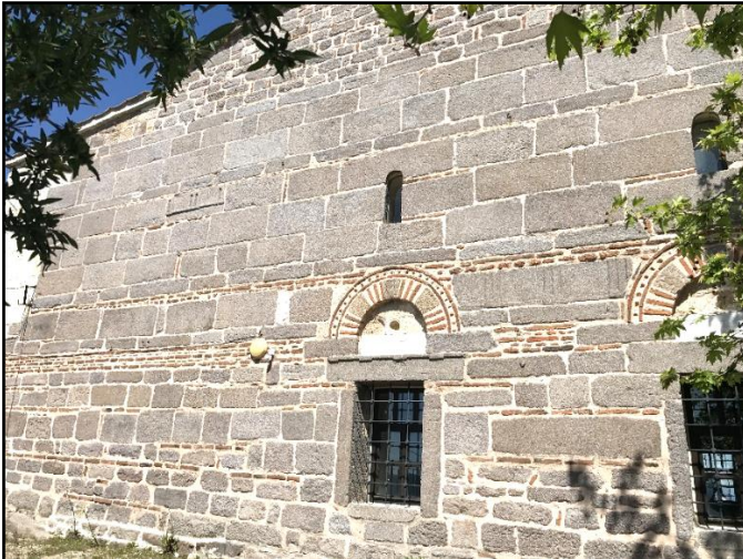
Şekil 2. 10. Hüdevendigar Cami sol cephe fotoğrafı (Asan, 2019)
