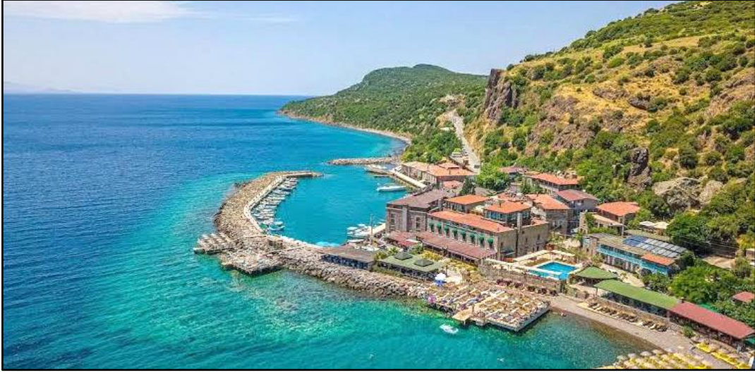
Şekil 3. 65. Liman bölgesindeki yapıları kuşbakışı (URL11)
