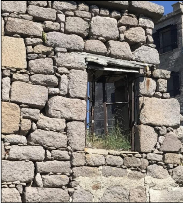
Şekil 2. 29. Ahşap lento örneği (Asan, 2017)
