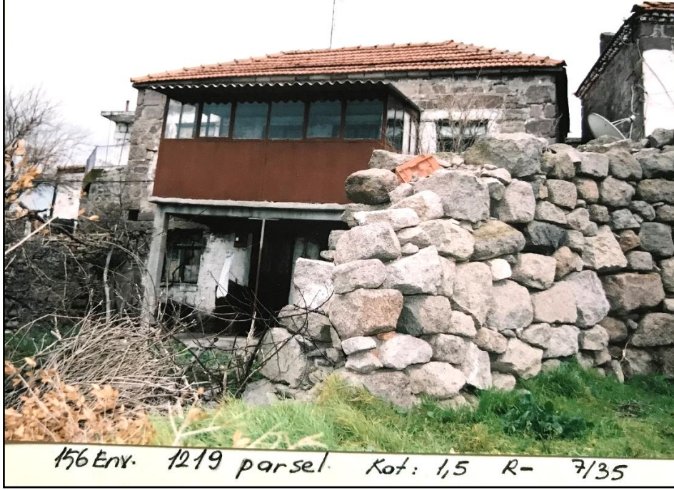
Şekil 3. 11. Yapılarda sahanlık kullanımındaki değişim (Çanakkale Kültür Varlıklarını Koruma Bölge Kurulu Müdürlüğü arşivi)
