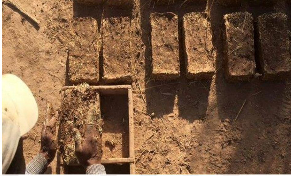
Şekil 3.2.Eski çağlarda lif (saman) takviyeli kerpiç yapımı [33]
