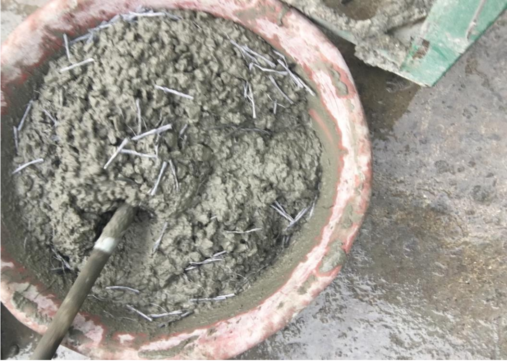
Şekil 4.13.Macromesh54 sentetik liflerin betona homojen olarak karılması
