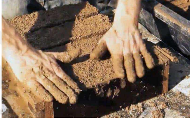
Şekil 3.1.Saman takviyeli kerpiç yapımı [32]
