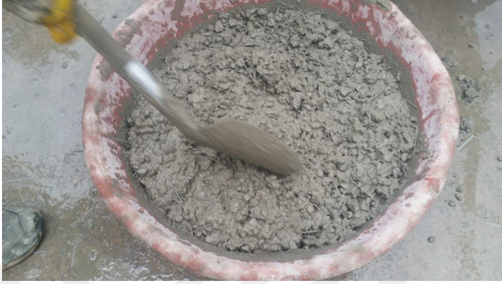
Şekil 4.11.Enduro prime sentetik liflerin betona homojen olarak karılması
