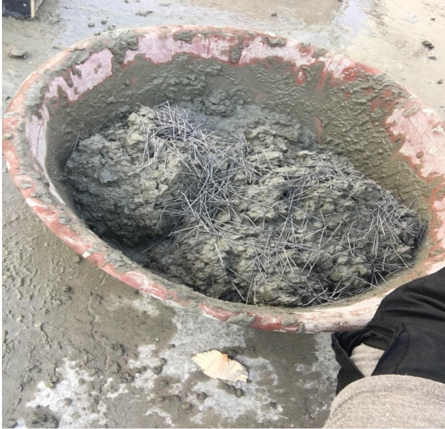
Şekil 4.8.HE1050 çelik lifinin betona karma işlemi
