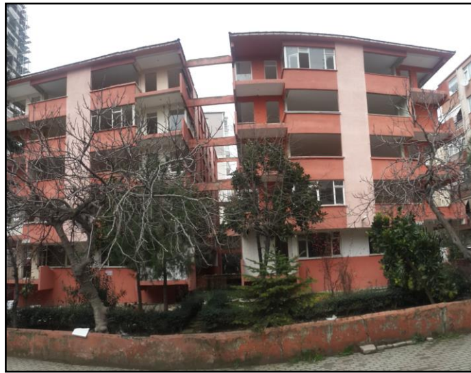
Şekil 30. İncelenen betonarme binalar
