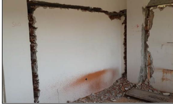
Şekil 16. Duvar ayırma sonrasında yapı içinden görünüş (Aras, 2018b)
