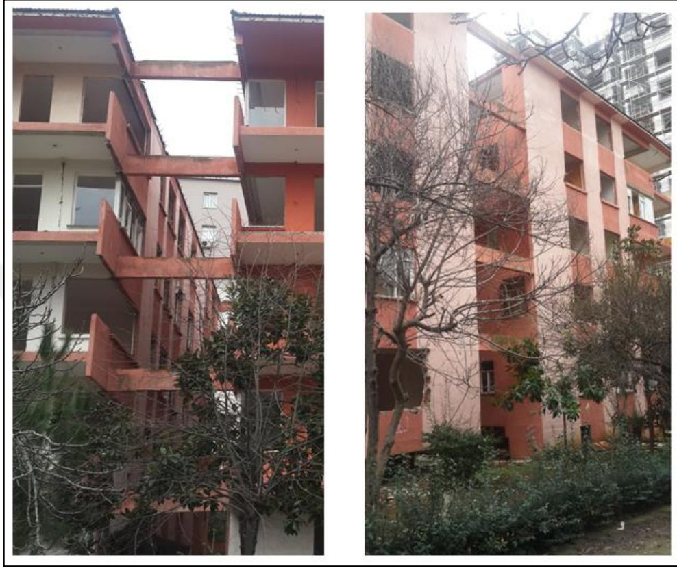
Şekil 34. Ön ve arka bölümde bulunan bağ kirişleri
