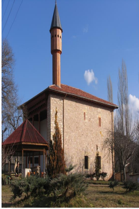
Şekil 6. Restorasyon sonrası minare (Kastamonu Vakıflar Bölge Müdürlüğü Arşivi, 2005)
