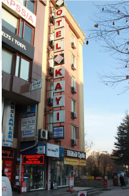
Fotoğraf 62. Hasar görmüş otel tabelası (Araştırmacı tarafından fotoğraflanmıştır)
