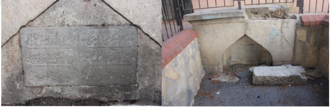
Fotoğraf 32. Bir ilkokul bahçesindeki yarısına kadar betonla gömülü Osmanlı Dönemi'nden kalma kitabeli çeşme (Araştırmacı tarafından fotoğraflanmıştır)
