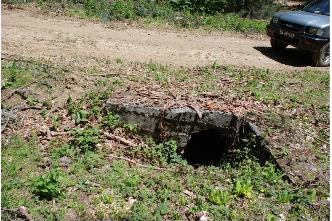
Şekil 4.5 Tekniğine uygun olarak yapılmış bir sepet kulplu yerinde dökme büz
