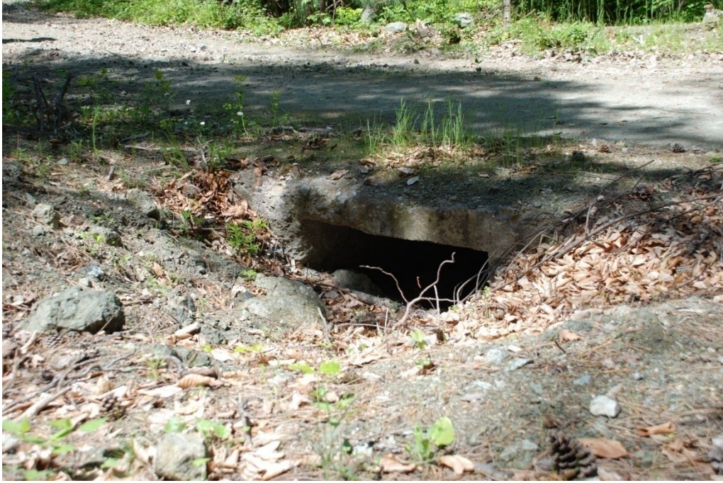
Şekil 4.4 Bakımı yapılmadığı için dolmuş kutu menfez
