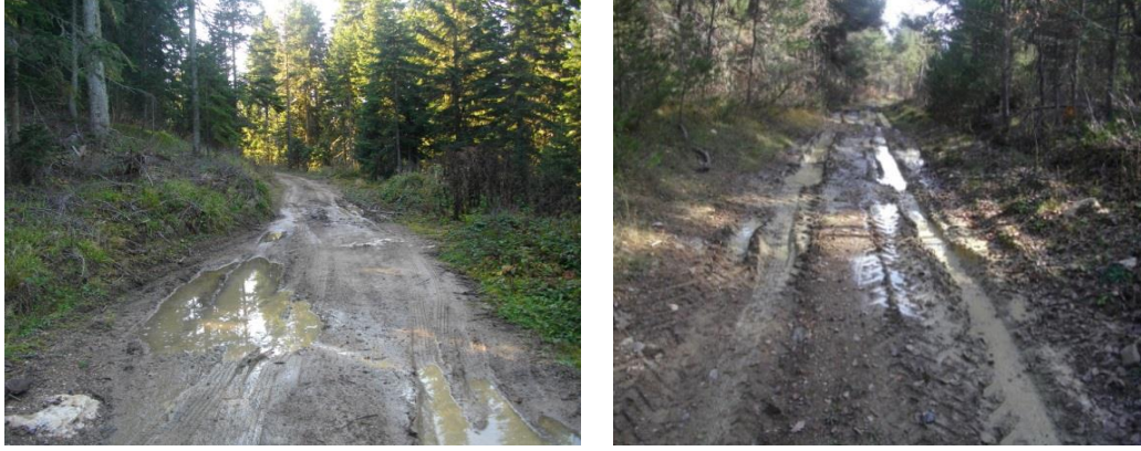
Fotoğraf 3.7. Yol yüzeyindeki bozulmalar
