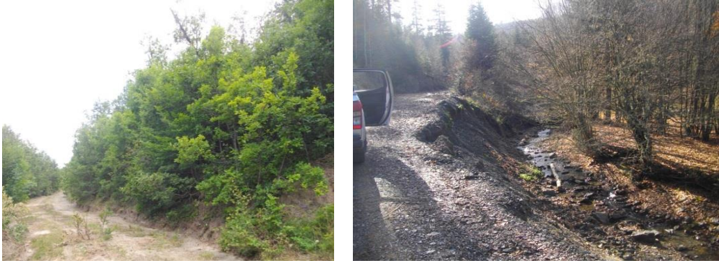
Fotoğraf 3.6. Kazı-Dolgu sevi stabilizasyonları
