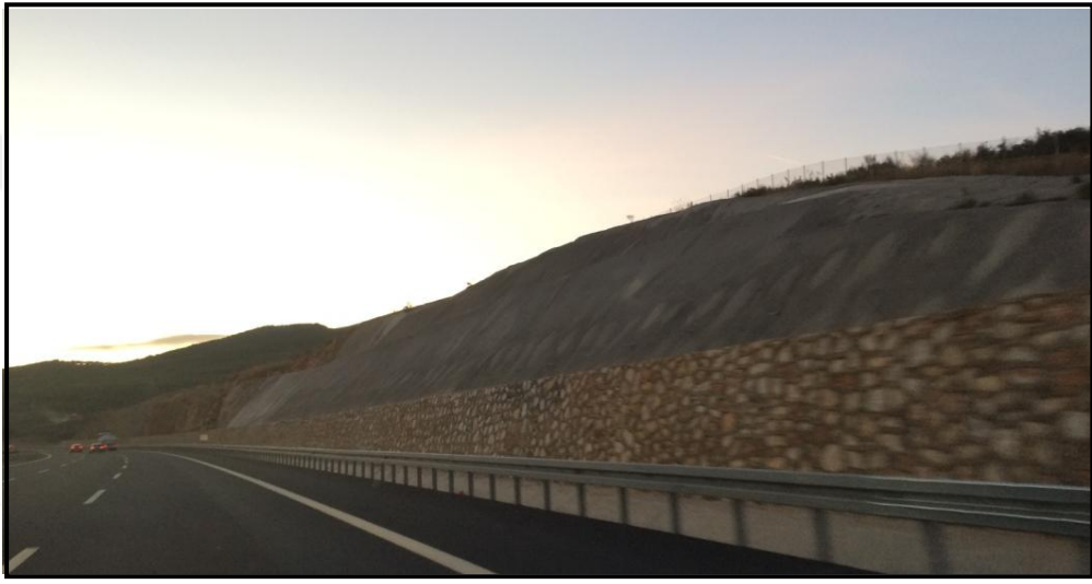
Fotoğraf 1.1. Farklı cansız materyallerle yamaç yüzeylerinin kaplanması
