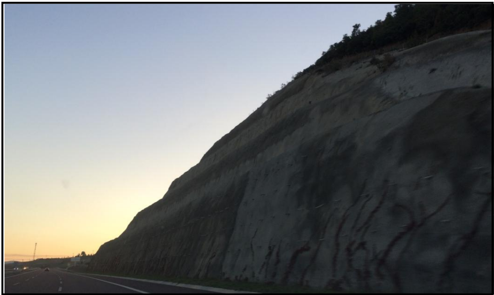
Fotoğraf 1.2. Cansız materyal ve bitkilerin beraber kullanıldığı yüzey kaplaması
