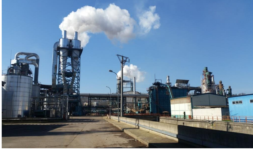
Şekil 1.6. Kurutma hattının sonlandığı ve liflerin toplandığı siklonlar
