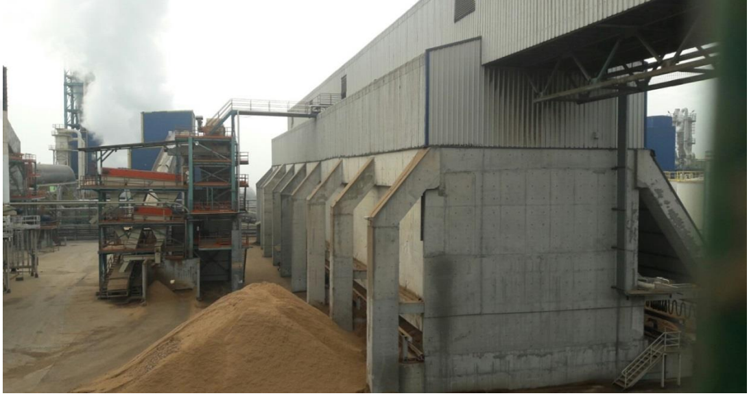
Fotoğraf 1.6. Beton yonga silosu Kastamonu Entegre Kastamonu Tesisi
