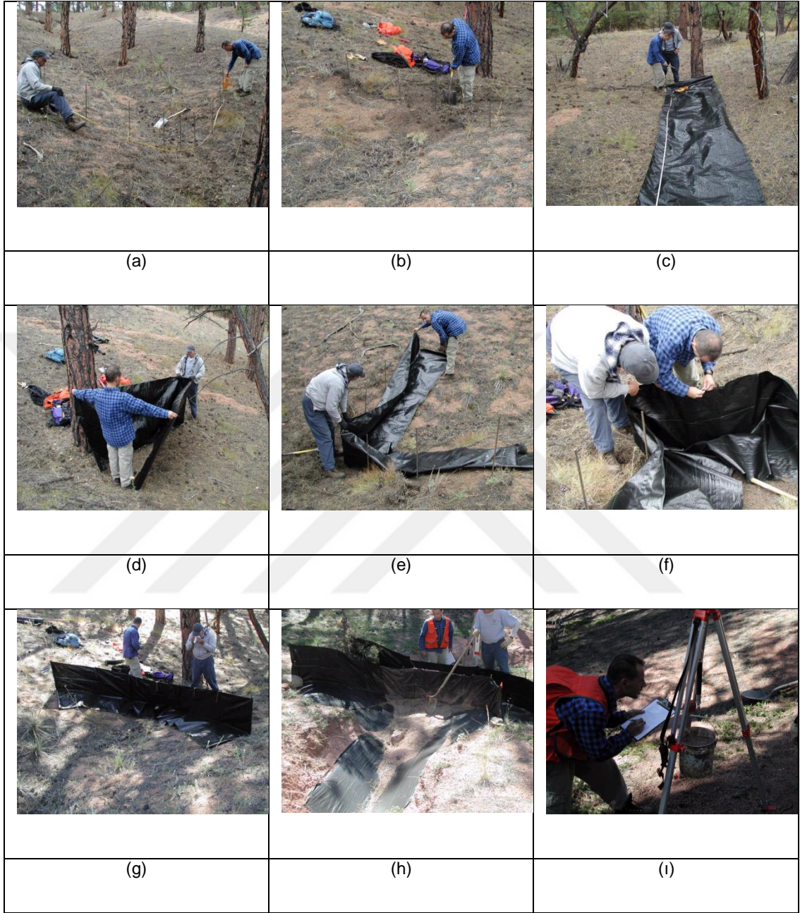
Fotoğraf 3.4. Sediment tuzasının kurulması (USFS)
