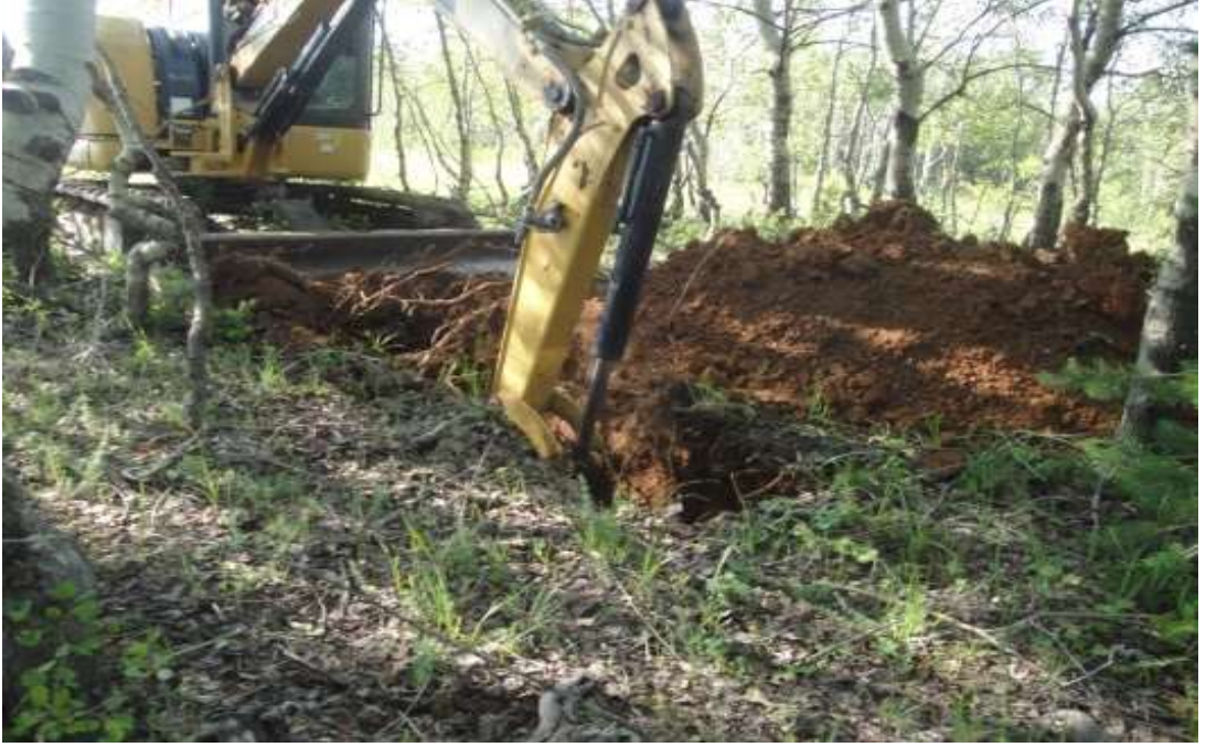
Fotoğraf 3. 8. Mini ekskavatör ile çukur açımı
