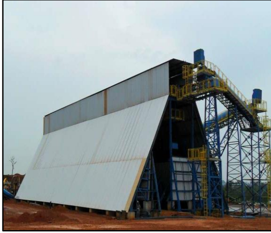
Fotoğraf 1.6. Depolama amacıyla kullanılan silolar(a. Horizontal silo (URL-12, 2016), b.Vertikal silo (URL-13, 2015)).
