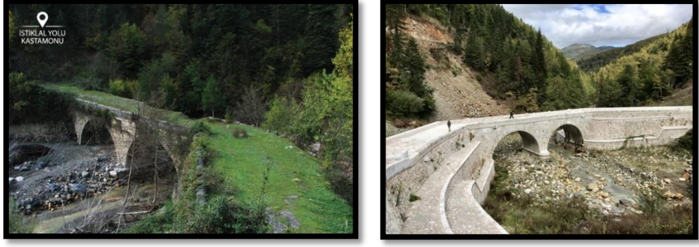
Şekil 3.40. İkiçay Köprüsü Restorasyondan Önceki ve Sonraki Hali (Anonim, 2018)
