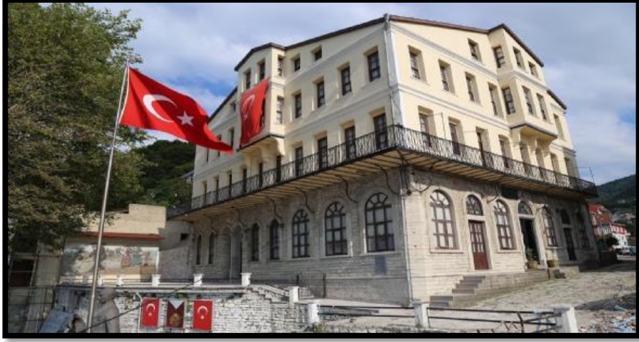
Şekil 3.37. İnebolu Türk Ocağı Binası (Anonim, 2018)
