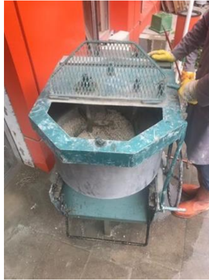
Şekil 3.10. Hafif beton malzemelerinin karıştırılması
