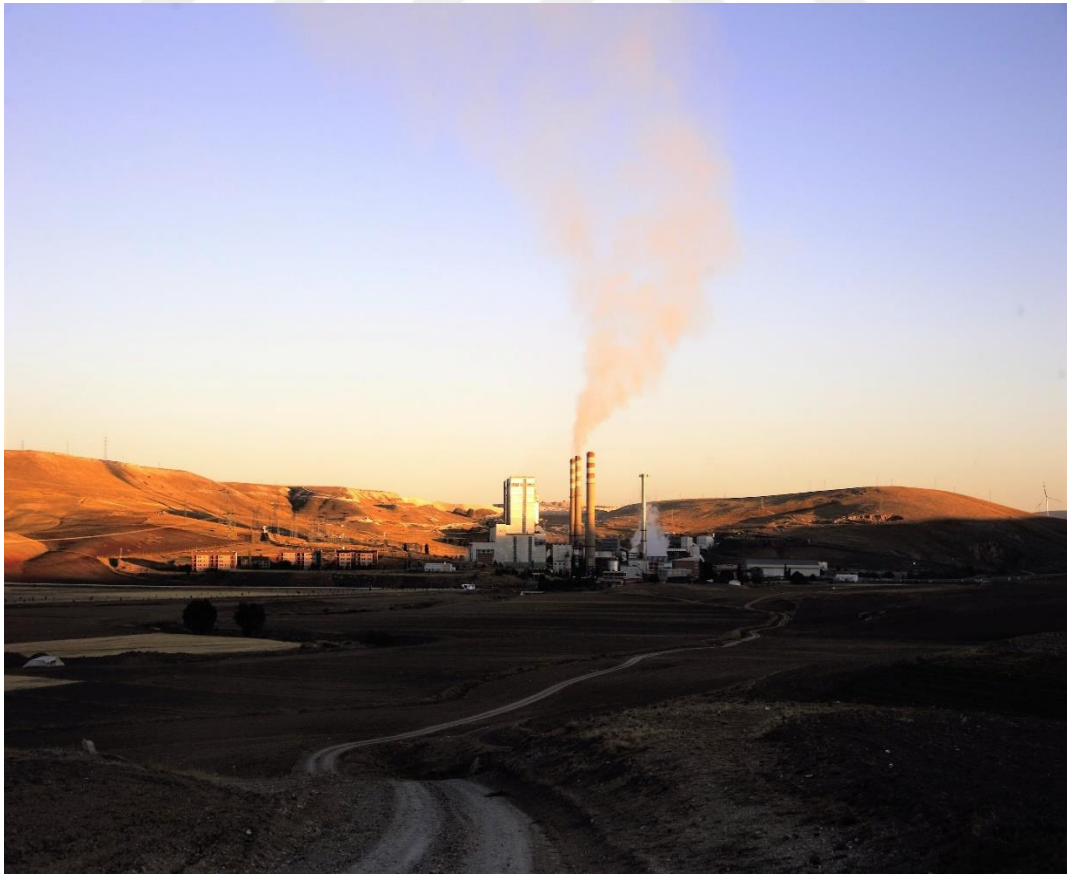
Fotoğraf 3.1. Kangal Termik Santralinin farklı açılardan görünümü
