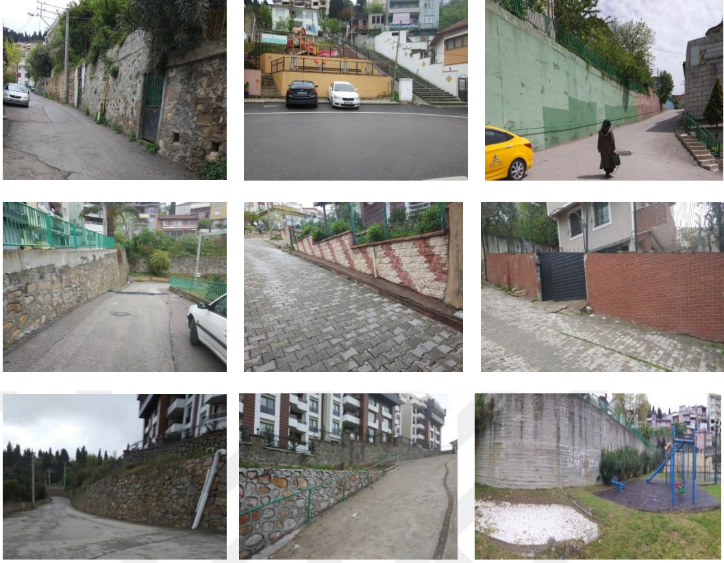
Şekil 4.20. Hacihızır Mahallesi'ndeki duvar örnekleri
