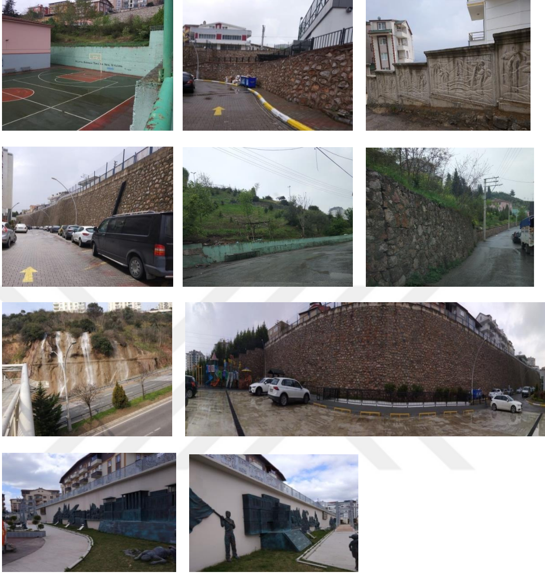
Şekil 4.16. Topçular Mahallesi'ndeki duvar örnekleri
