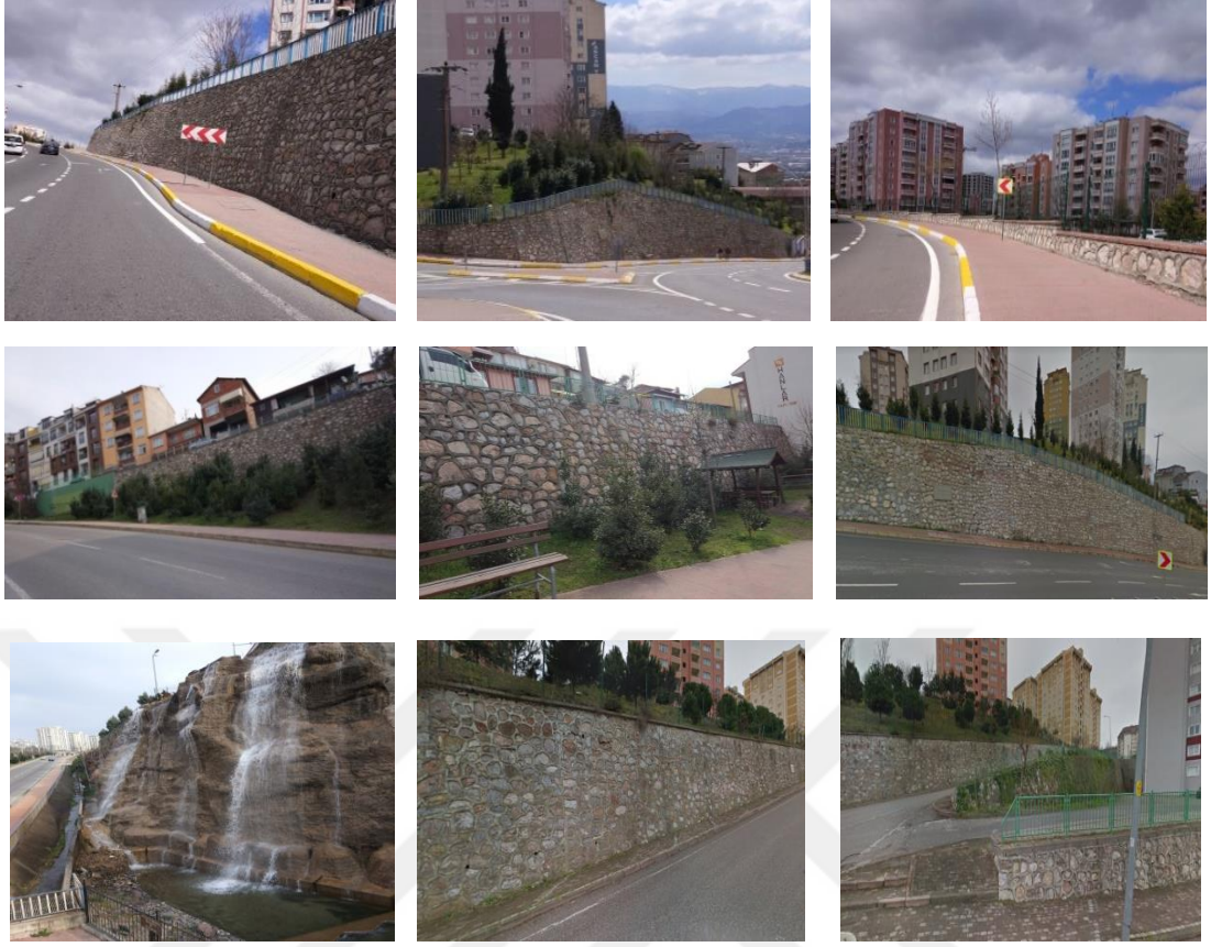
Şekil 4.7. Erenler Mahallesi'ndeki duvarlardan örnekler
