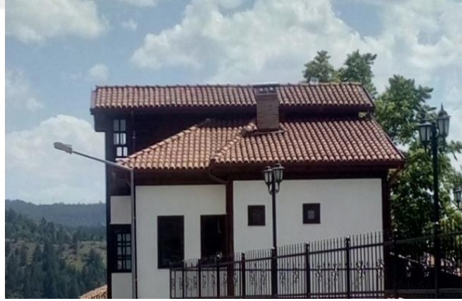
Fotoğraf 6.15. Çatı sağ cephe görünümü
