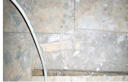
Fotoğraf 6.17. Çatı konstrüksiyonu ve çatı arası OSB zemin döşemesi
