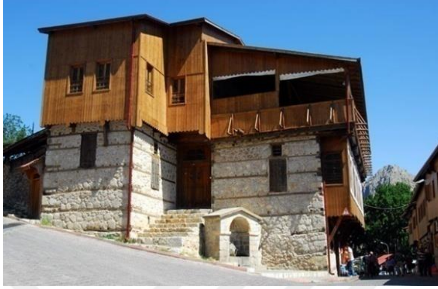
Fotoğraf 2.10. Kuzeydoğu Anadolu ahşap hatıllı taş mimarisi (Erzincan) (URL-11, 2018)
