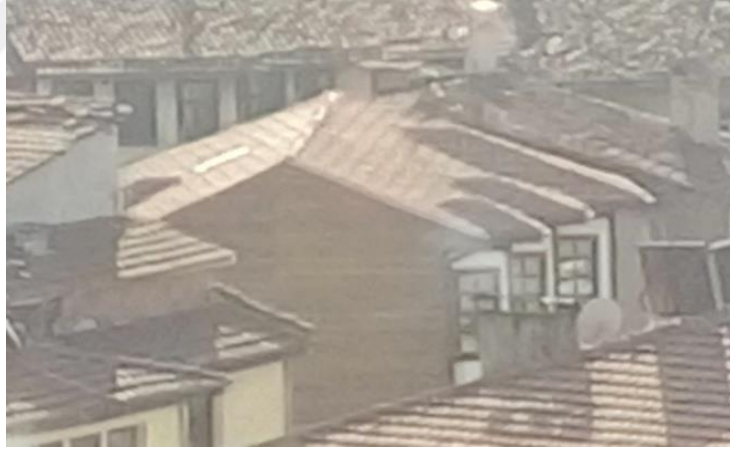
Fotoğraf 6.23. Aycılar Konağı çatı görünümü
