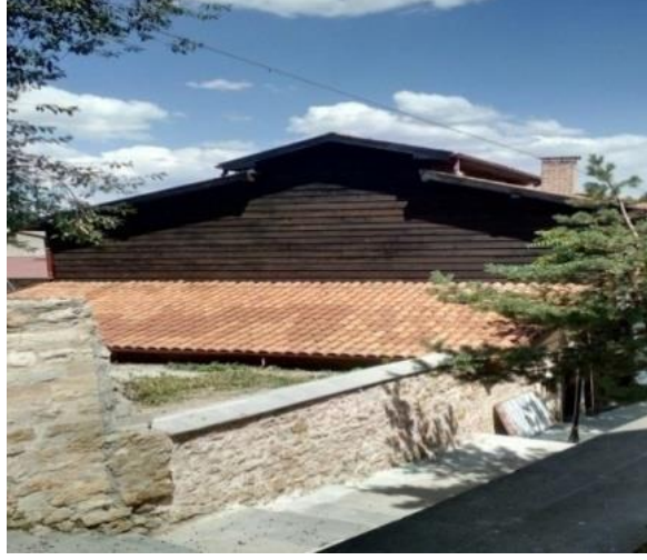
Fotoğraf 6.16. Sundurma çatı ve arka cephe görünümü
