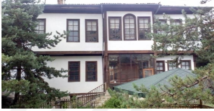
Sağ cephe görünümü
