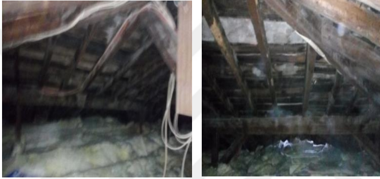
Merteke - orta aşık bağlantıları
