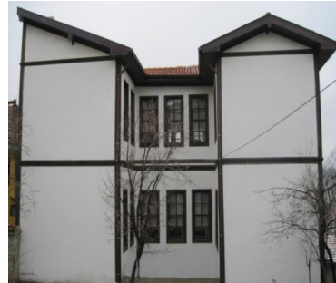
Restorasyon öncesi ve sonrası arka cepheden görünüm (URL-85, 2018)
