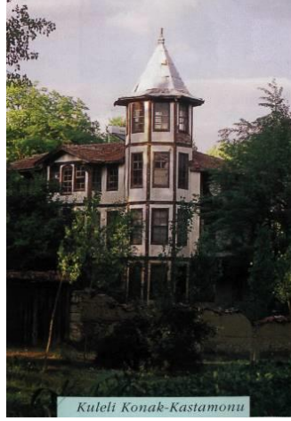
Fotoğraf 6.26. Konağın kule kısmından görünüşü (URL-85, 2018)
