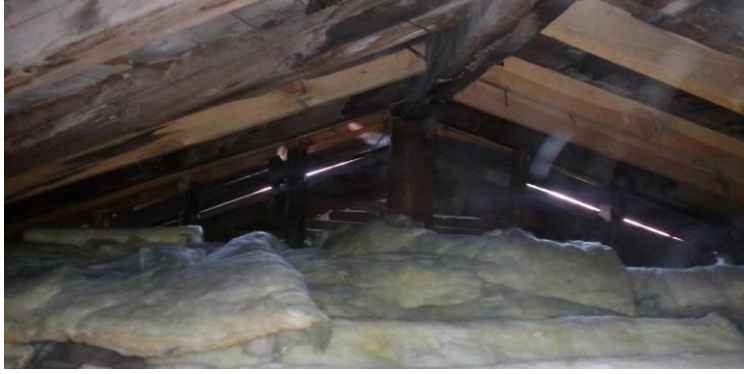
Mahya-dikme- merteke bağlantısı
