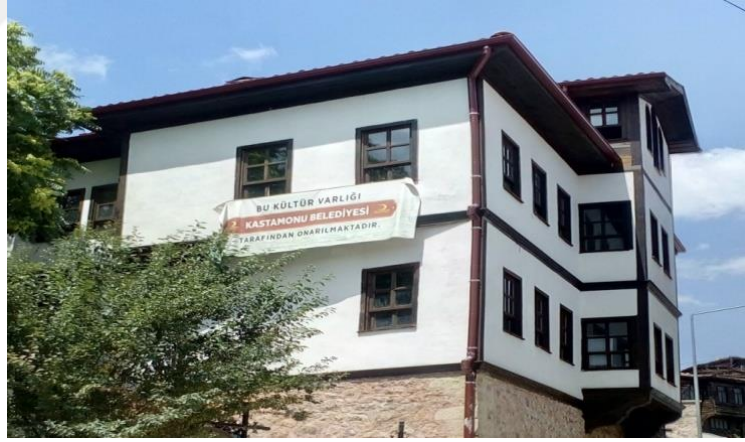
Fotoğraf 6.19. Saçak ve yağmur oluğu görünümü
