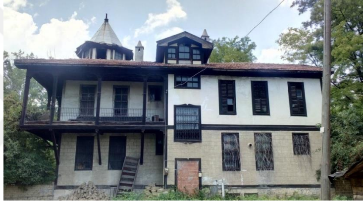
Fotoğraf 6.27. Corukzade Konağı
