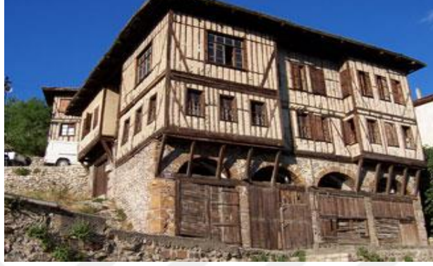
Fotoğraf 2.23. Ahşap karkas sistem (URL-20, 2018)
