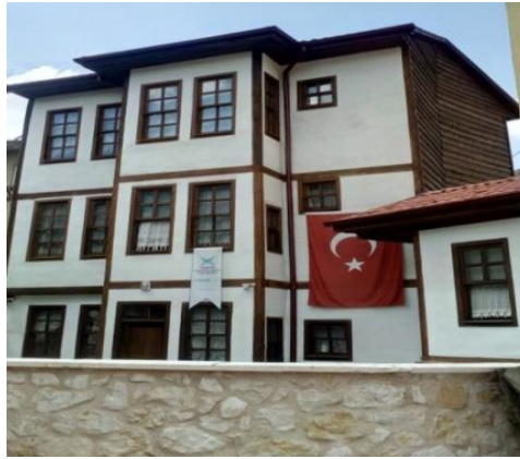
Fotođraf 6.21. Aycılar Konađı arka cephe görünümü (URL-83, 2018)
