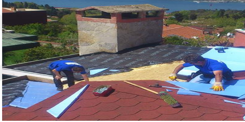
Fotoğraf 4.15. Çatıda su yalıtımı için kaplama işlemi (URL-68, 2018)
