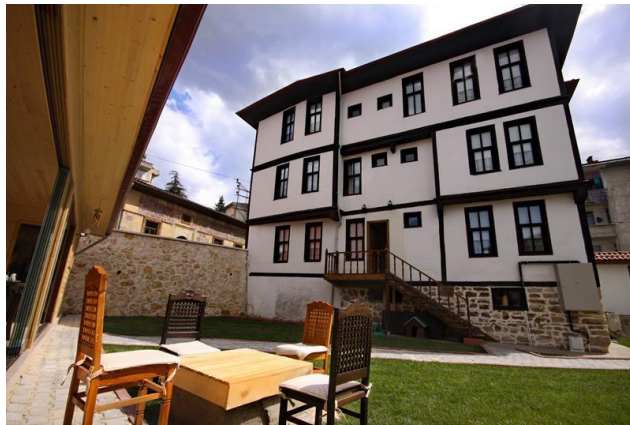
Fotođraf 6.50. Kadiođlu Konađı arka cephe görünüşü (URL-97, 2018)
