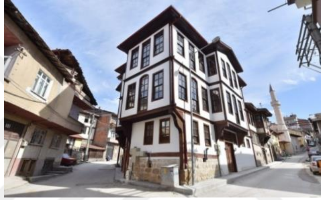
Fotoğraf 6.7. Aktekke Konağı arka cephe görünüşü (URL-81, 2018)
