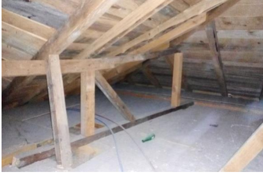
Fotoğraf 6.17. Çatı konstrüksiyonu ve çatı arası OSB zemin döşemesi
