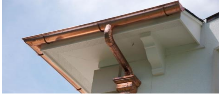
Fotoğraf 4.17. Bakır yağmur suyu oluđu ve boruları (URL-70, 2018)
