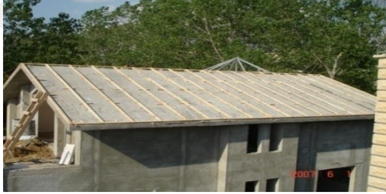
Fotoğraf 3.15. Betonarme çatı (URL-36, 2018)
