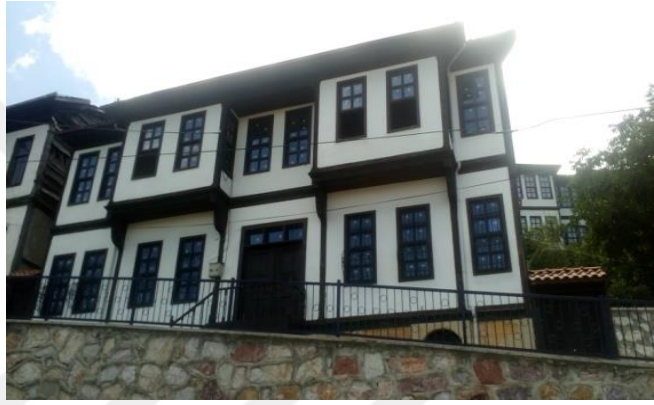
Fikret Konağı görünümü
