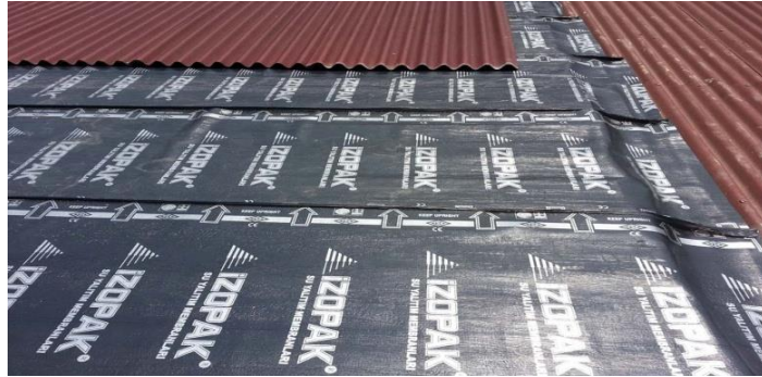
Fotoğraf 4.12. Bitümlü membran üstü ondülin levha kaplama (URL-63, 2018)
