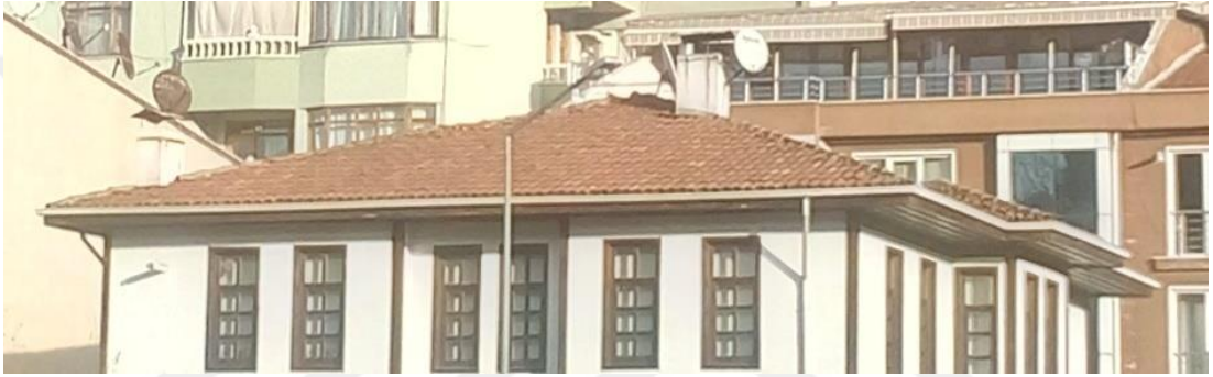
Fotoğraf 6.68. Çatı sol cephe görünümü
