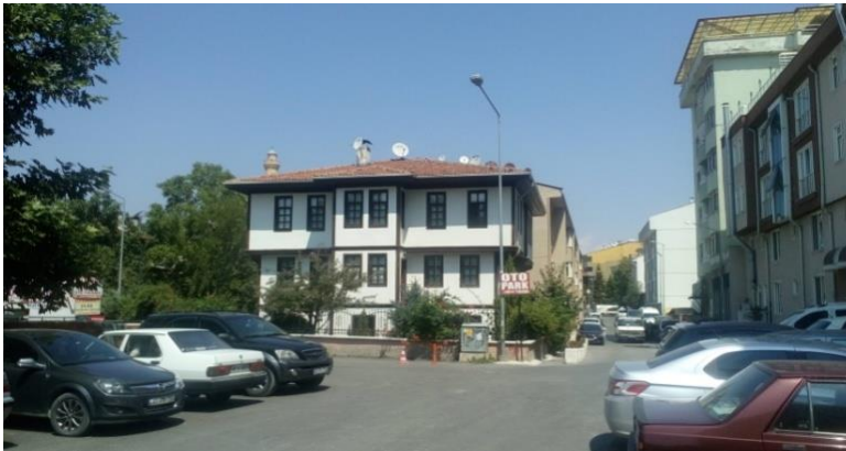
Ön cephe görünümü
