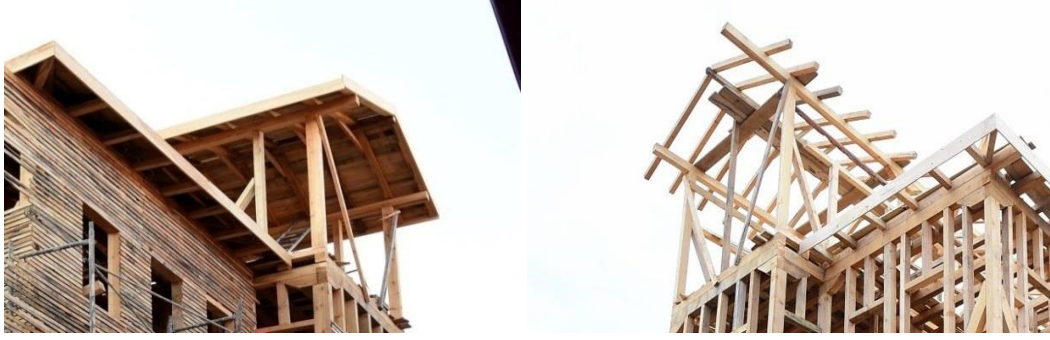
Fotoğraf 6.14. Fenerli çatı restorasyonu (URL-82, 2018)
