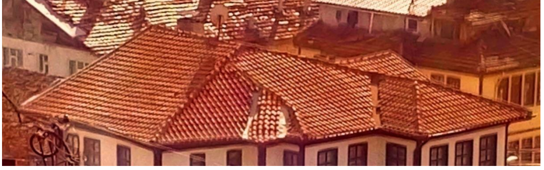
Fotoğraf 6.10. Aktekke Konağı çatı görünüşü
