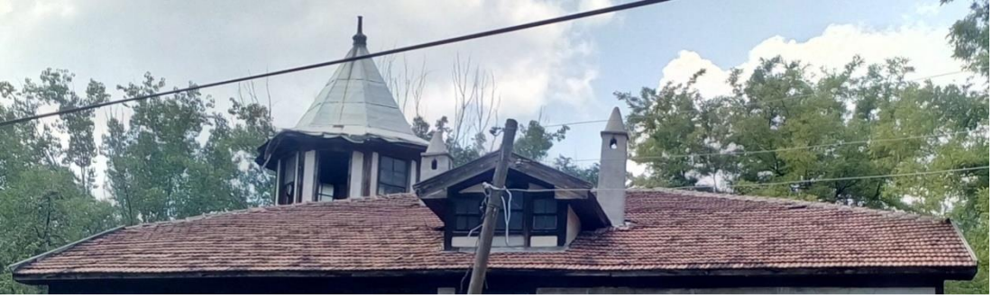
Fotoğraf 6.28. Konağın çatı ve kule görünümü
