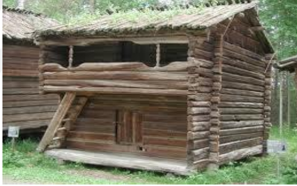
Fotoğraf 2.24. Ahşap yığma sistemli yapı (URL-21, 2018)
