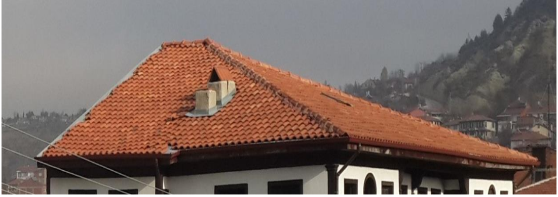
Fotoğraf 6.35. Çatı ön-sol cephe görünüşü
