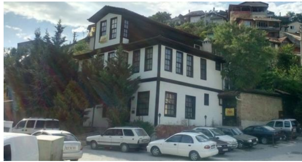
Fotoğraf 6.65. Toprakçılar Konağı restorasyon öncesi görünümü (URL-95, 2018)
