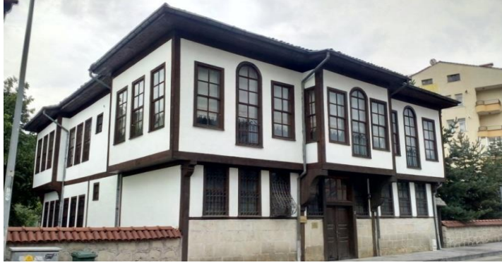
Ön ve sol cephe görünümü
