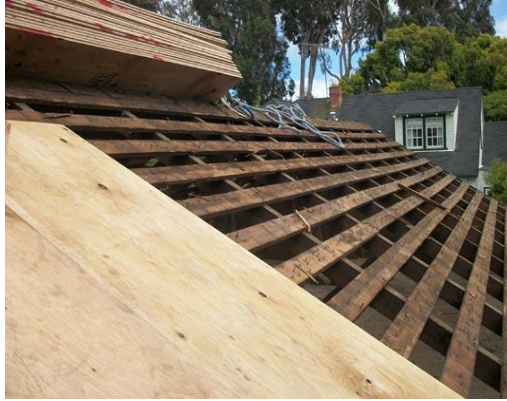
Fotoğraf 4.6. Kontraplak ile kaplama (URL-56, 2018)
