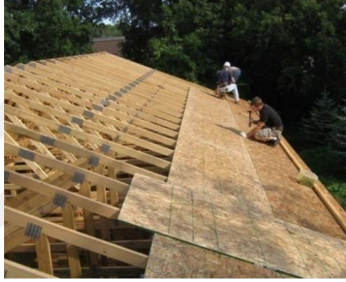
Fotoğraf 4.5. OSB levha ile kaplama (URL-55, 2018)
