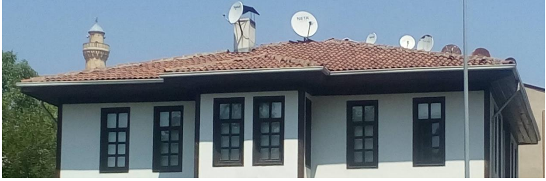
Fotoğraf 6.67. Çatı ön cephe görünümü
