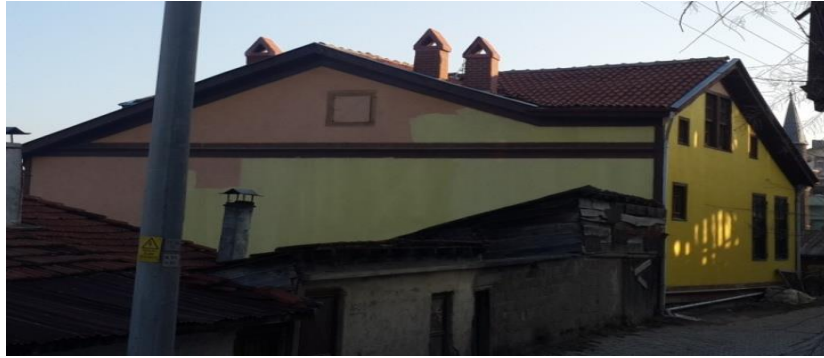
Arka ve sağ cephe görünümü
