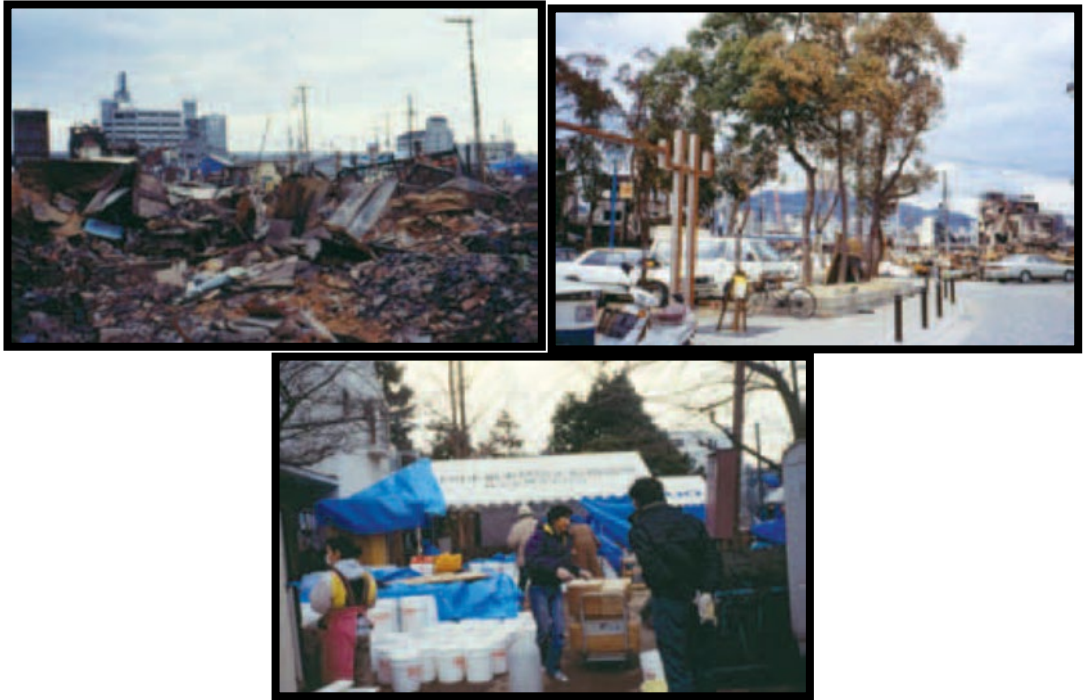
Şekil 2.14. Hanshin-Awaji Depreminden Sonra Sağ Üst Resimde Yoğun Ahşap Evlerin Parçalanmış Hali, Sol Üst Resimde Ahşap Konut Alanlarında Yangının
