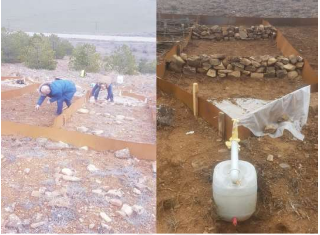
Şekil 3.6. Taş kordon yapımı ve parseli
