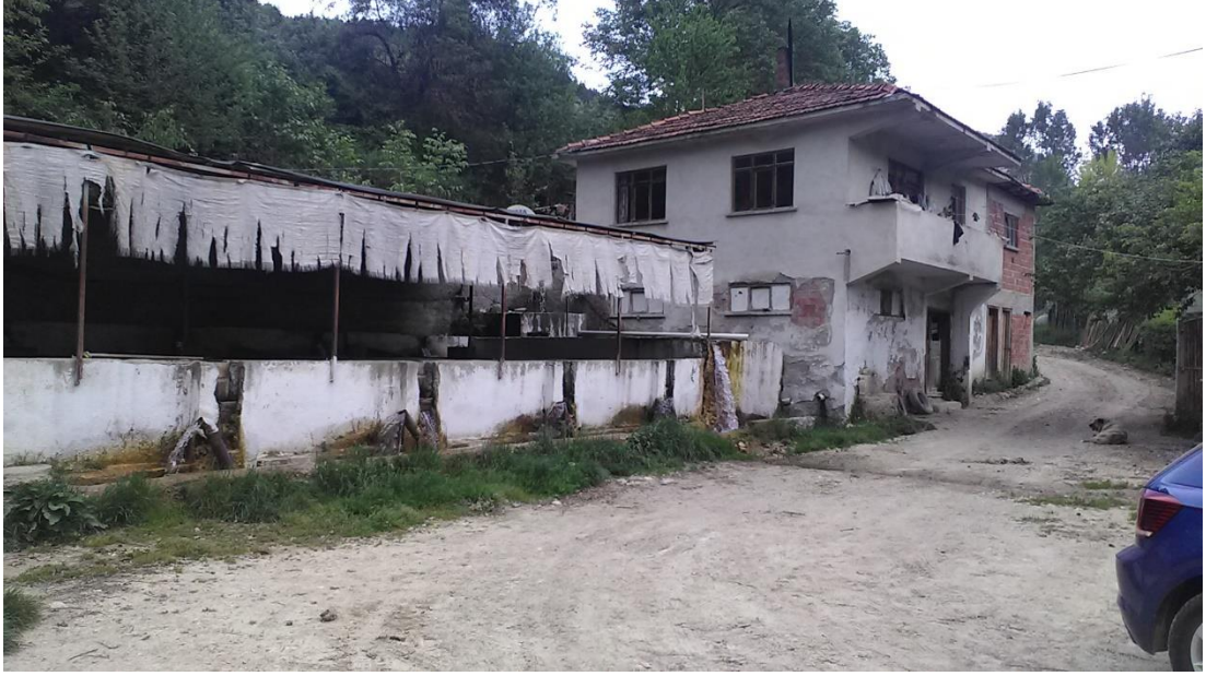
Şekil 4.10. Yürekveren alabalık tesisi işletme binası
