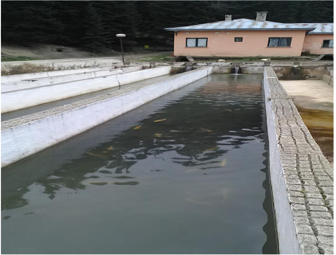
Şekil 4.34. Baldıran alabalık tesisinde yer alan beton havuzlar
