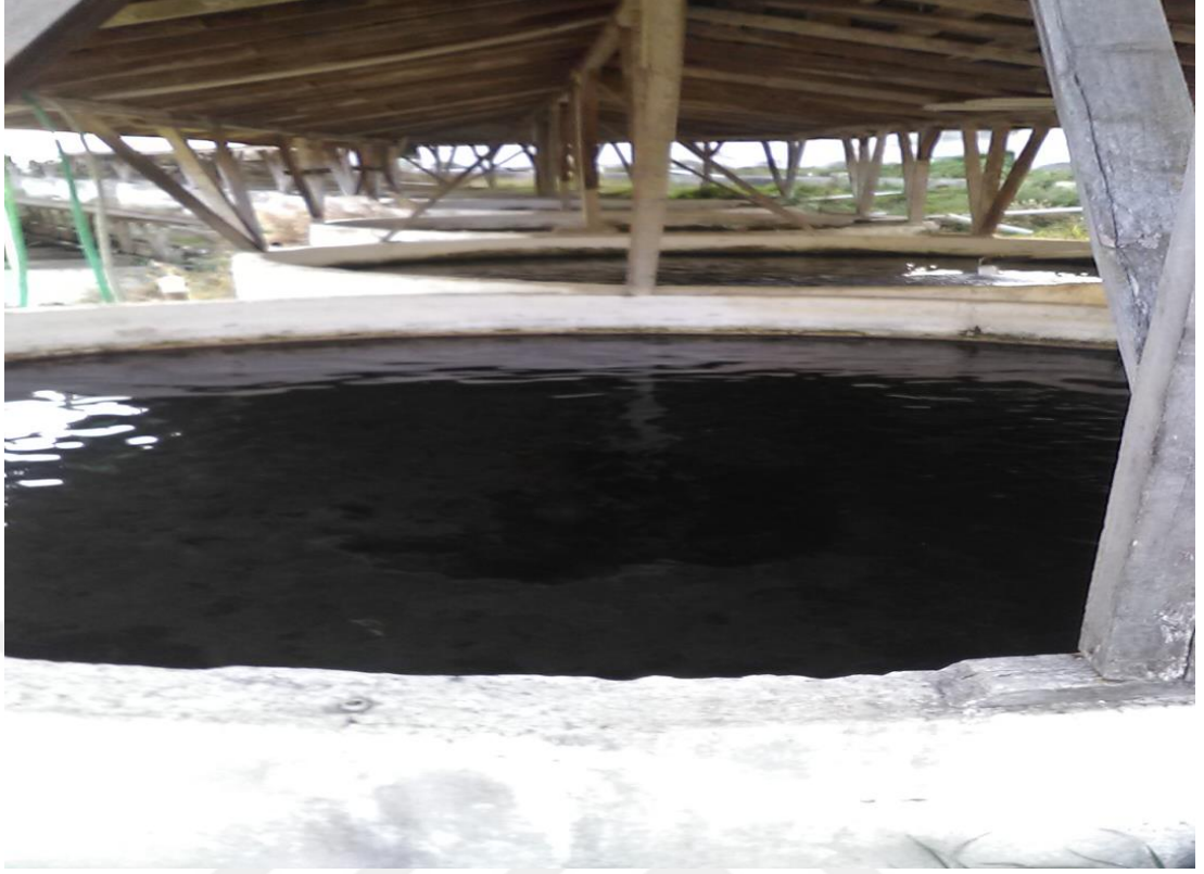
Şekil 4.19. Çağlayan alabalık tesisinde bulunan yuvarlak şekilli beton havuzlar
