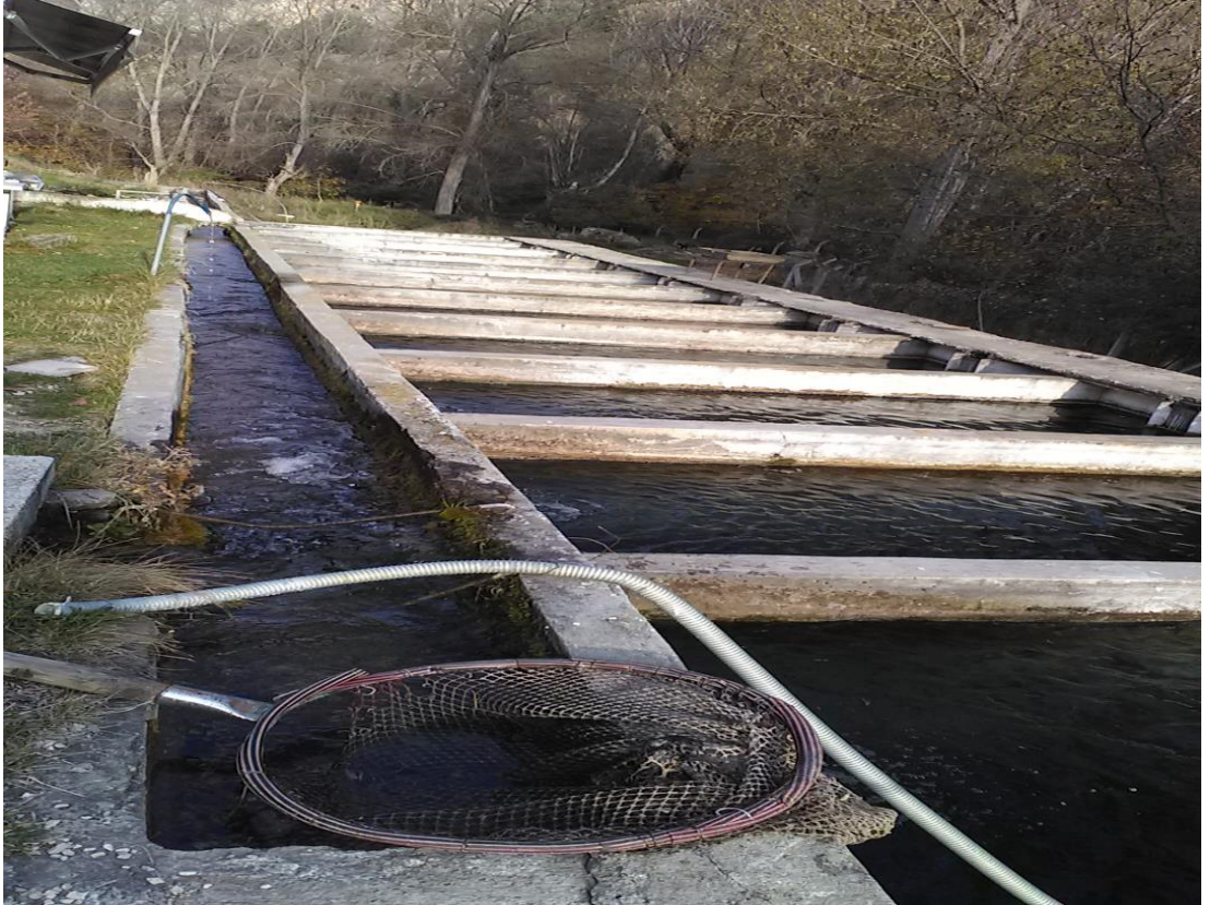
Şekil 4.18. Çağlayan alabalık tesisinde bulunan dikdörtgen şekilli beton havuzlar
