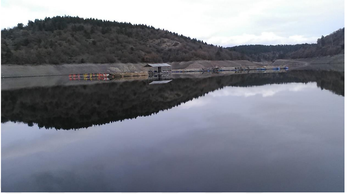
Şekil 4.25. Germeçtepe Barajı üzerine kurulu 75 ton kapasiteli alabalık tesisi (2)
