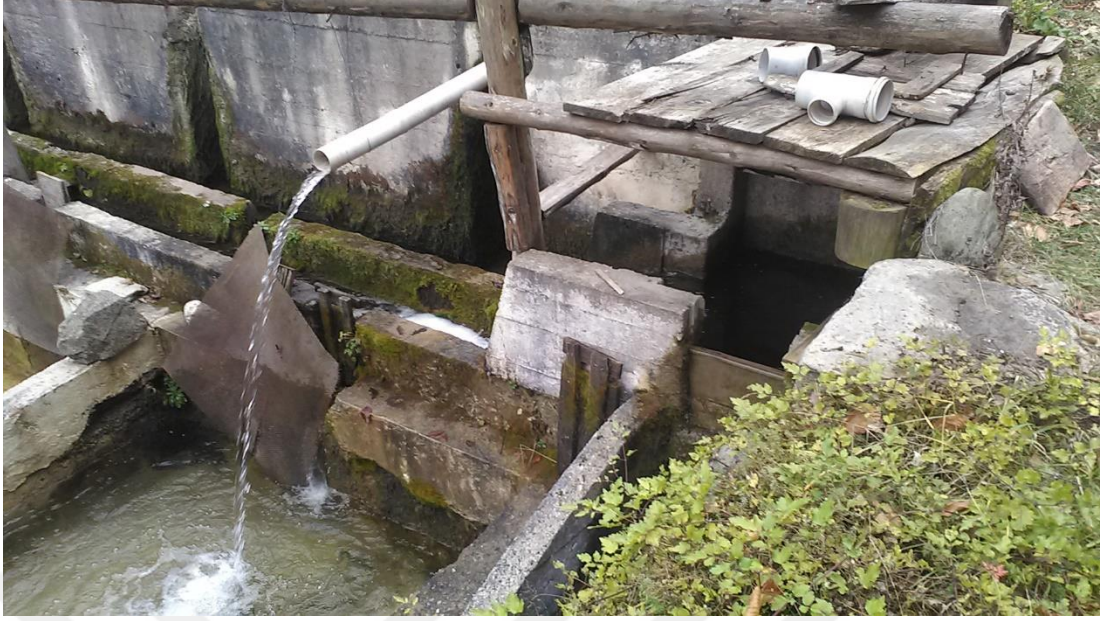
Şekil 4.3. Set alabalık tesisinde yer alan beton havuzlara su girişi
