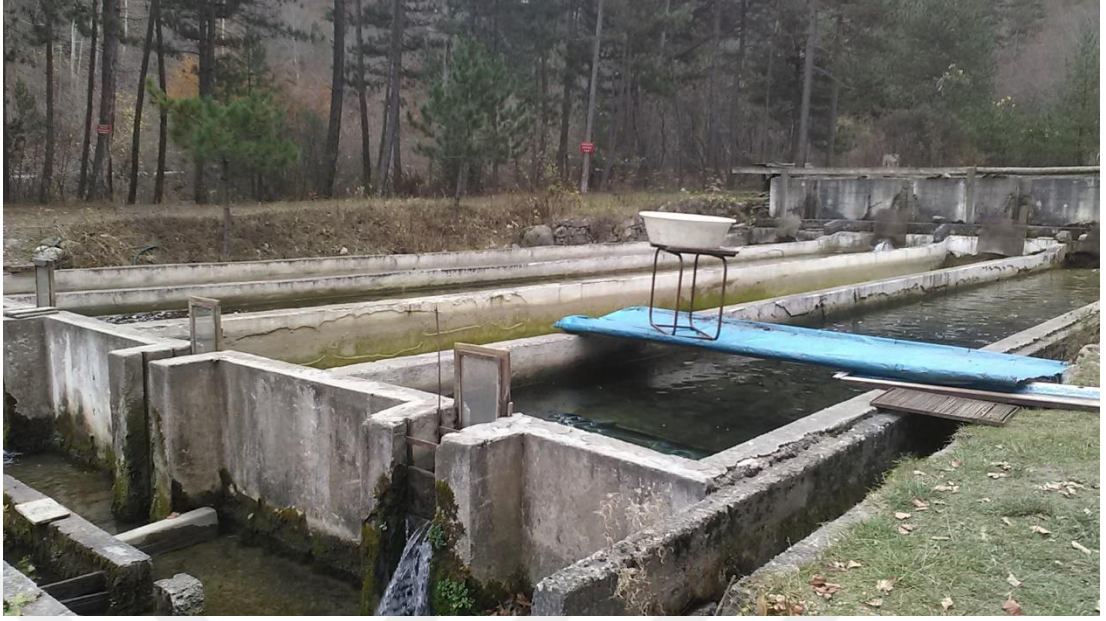
Şekil 4.4. Set alabalık tesisi beton havuzları
