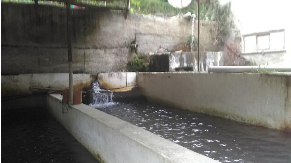
Şekil 4.11. Yürekveren alabalık tesisinin havuzlarına su girişi
