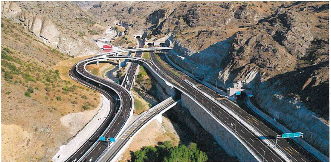
Şekil 1.2. Trabzon ve Erzurum illeri arasında ulaşımı sağlayan Gümüşhane çevre yolu örneği
