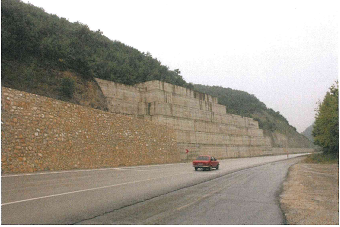
Şekil 1.3. Karayolunda istinat duvarına dair örnek (Bursa-Eskişehir yolu)
