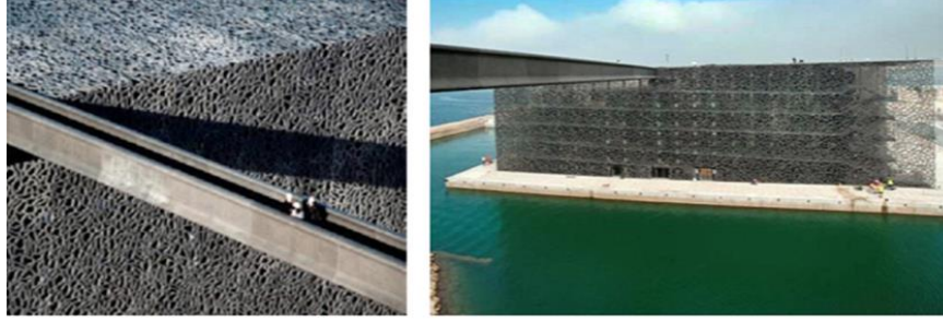
Şekil 2.21. MuCEM, UYPB kafes cepheli
