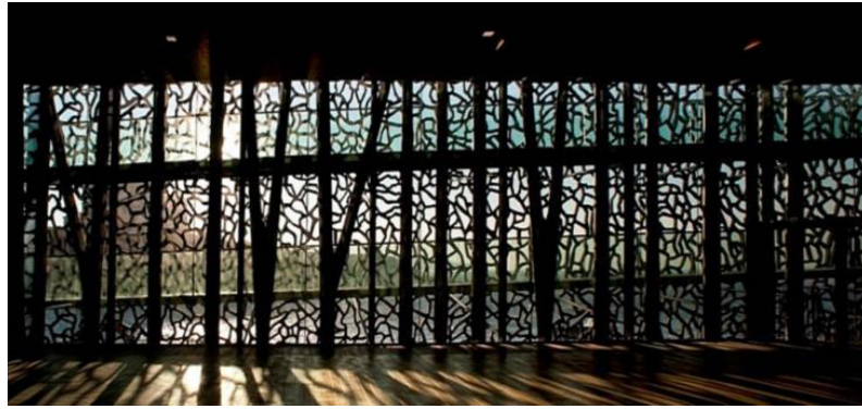
Şekil 2.20. MuCEM, UYPB kafes cepheli
