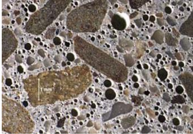
Şekil 2.6. Hava sürüklenmiş betonun içyapısı (Bostancı, 2014)
