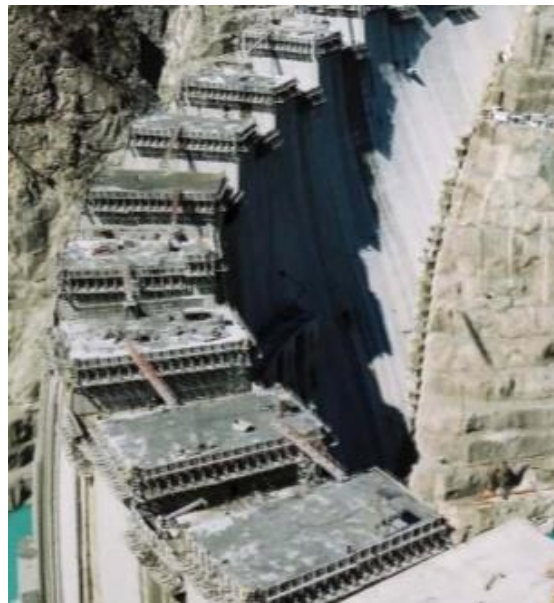
Şekil 2.2. Bir kemer baraj kütle betonu (Bostancı, 2014)
